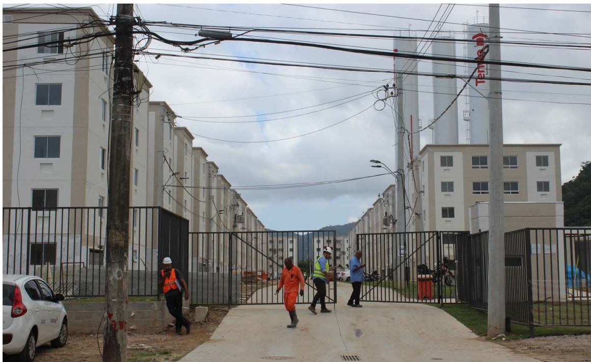
Foto 1 : fachada do condomínio
