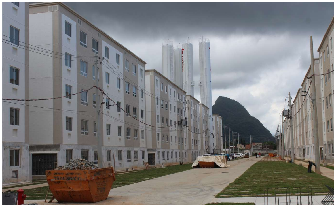
Foto 2 : situação atual da obra
