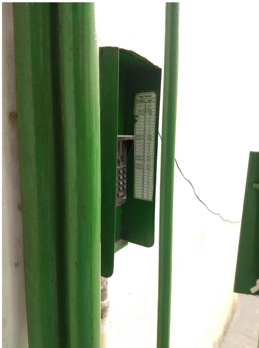
FOTO 4: Detalhe do interfone do portão social de acesso à vila.
