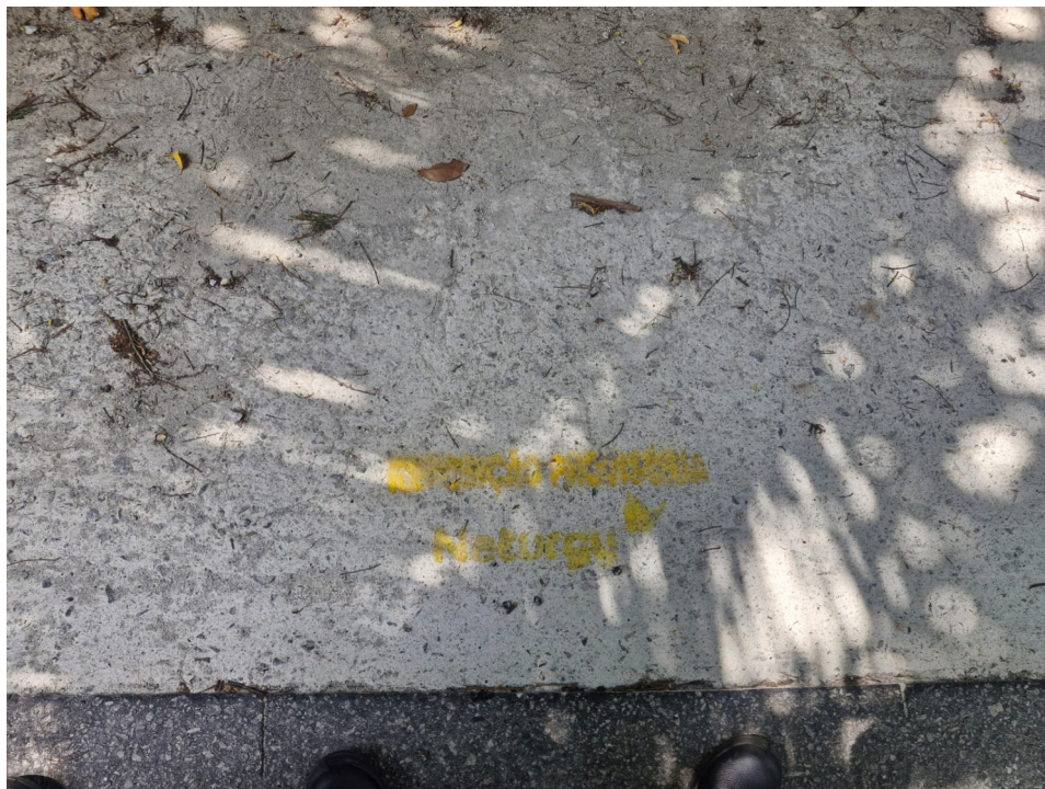
Foto 4: Trecho de recomposição provisória.
