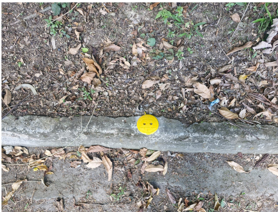
Foto 5: Trecho de assentamento de tubulação por método não destrutivo identificado com marco plano.
