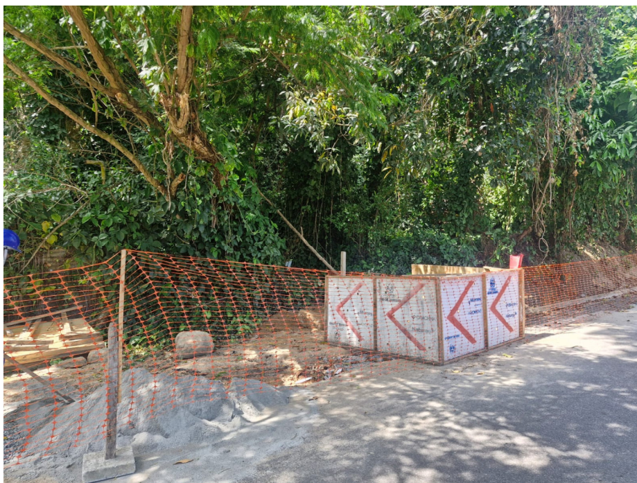
Foto 8: Isolamento da obra feito com tapume e rede tapume.
