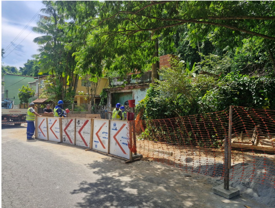
Foto 3: Trecho fiscalizado com assentamento de tubulação por método destrutivo (vala aberta).
