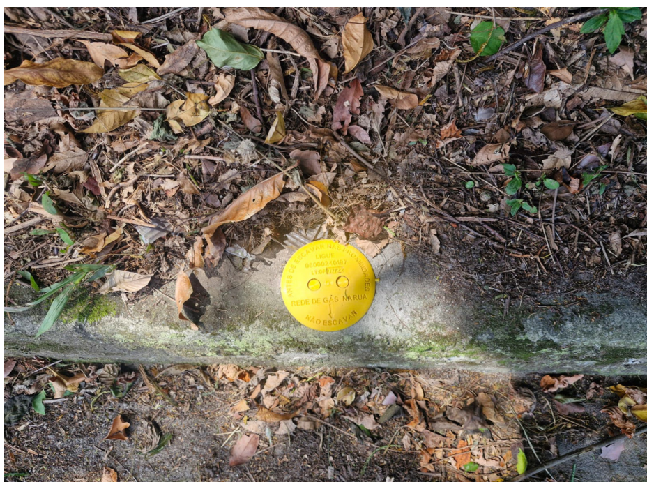
Foto 6: Trecho de assentamento de tubulação por método não destrutivo identificado com marco plano.
