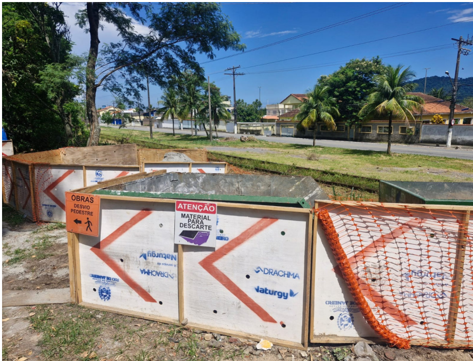
Foto 7: Isolamento da área de descarte de material feito com tapume e tela tapume e com sinalização adequada.
