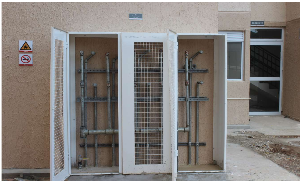
Foto 3 : instalação para regulador e medidores
