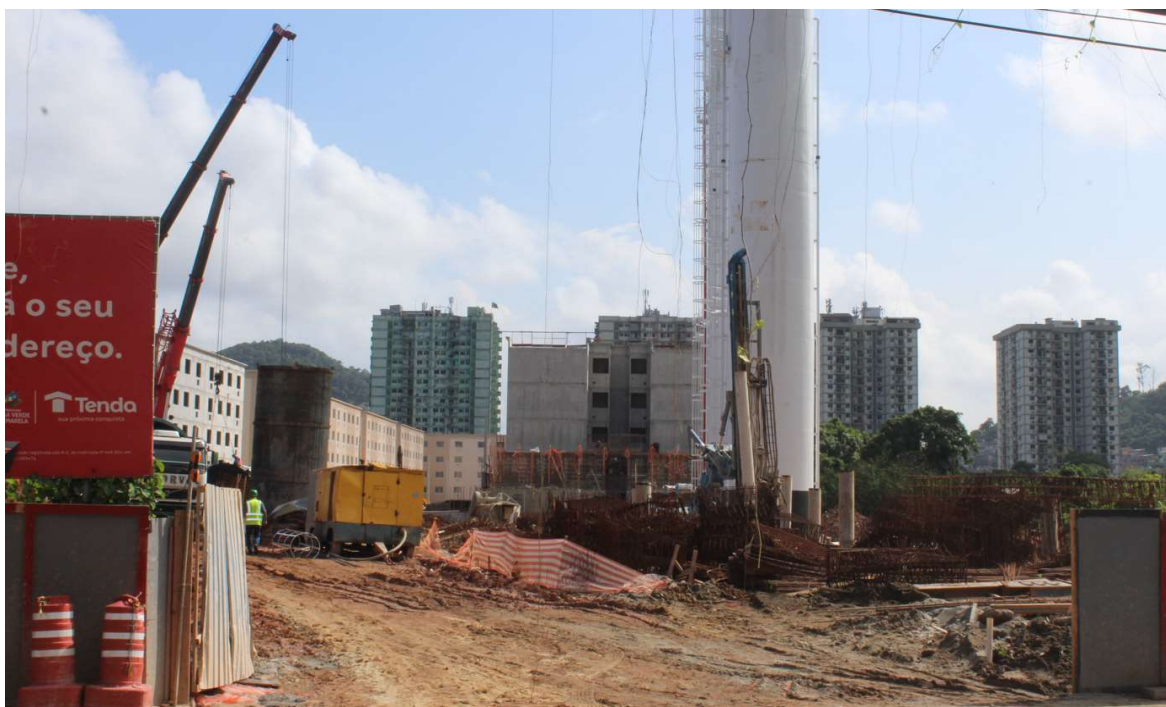
Foto 2 : situação atual da fachada
