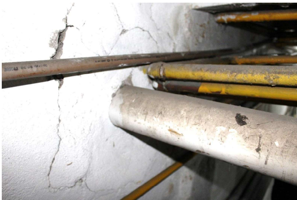
FOTO 6: Instalações de outras naturezas junto com tubulação de Gás Natural – PI.
