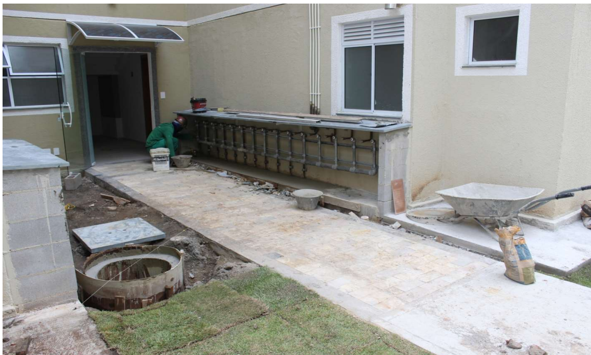
Foto 5 : Obra de instalações internas, de responsabilidade da Construtora ainda em andamento.
