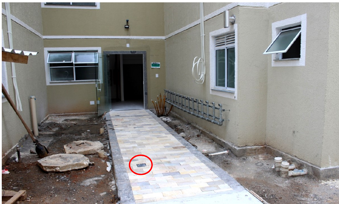
Foto 4 : Obra de instalações internas, de responsabilidade da Construtora ainda em andamento. Em destaque caixa de válvula de bloqueio do ramal.
