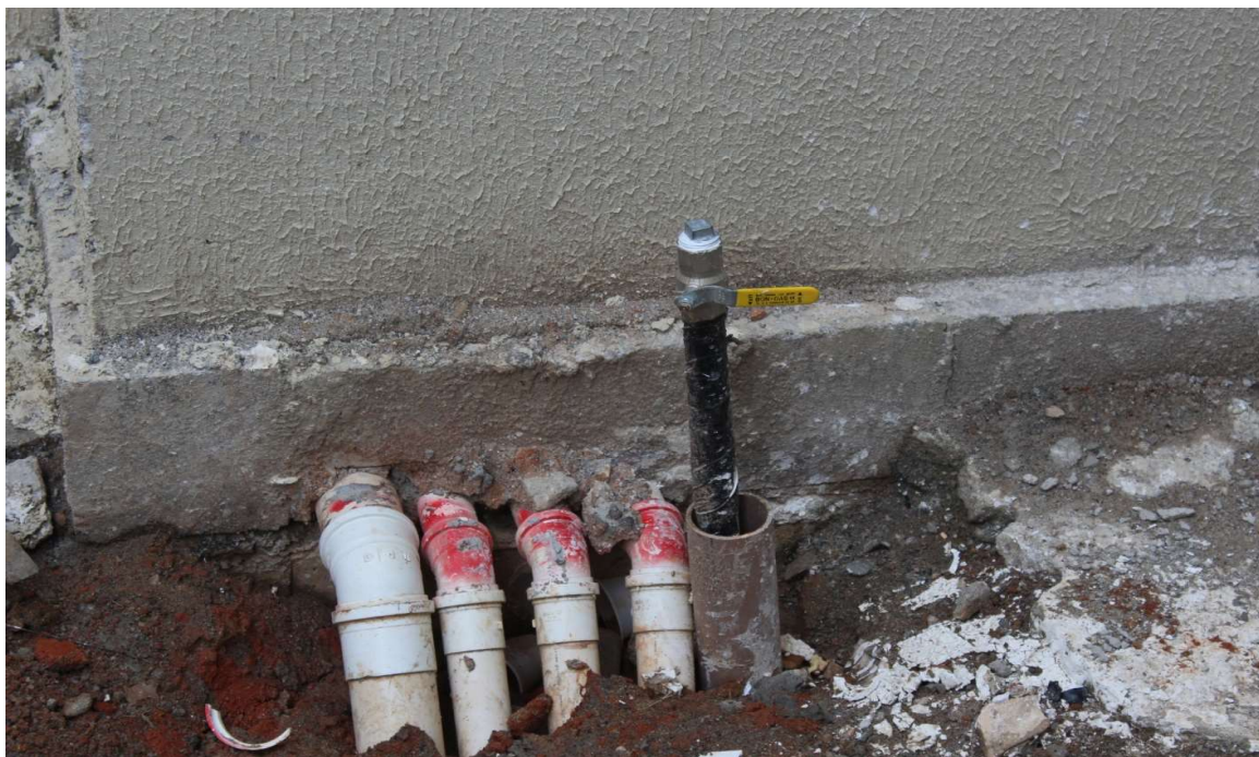
Foto 5 : Detalhe da saída do ramal para alimentar a cabine de medidores, que ainda será construída pela Construtora.
