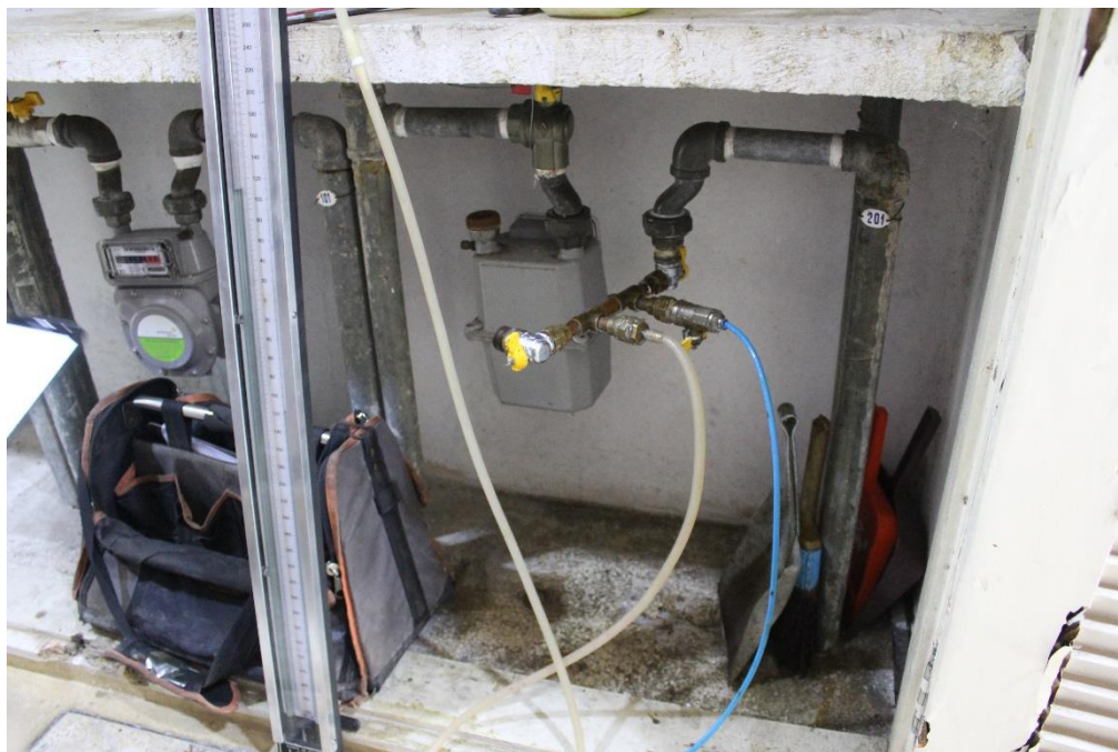
FOTO 5: Montagem dos equipamentos necessários para a realização do teste de estanqueidade.
