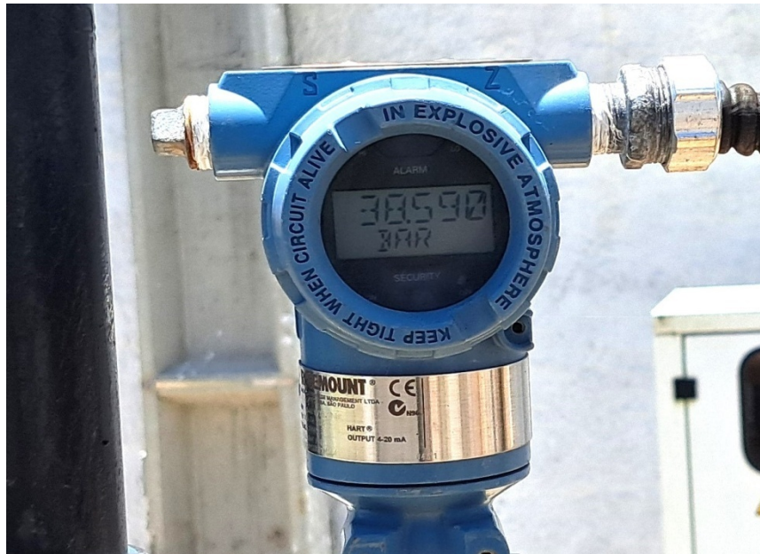
Foto 3: Medição da pressão de entrada
