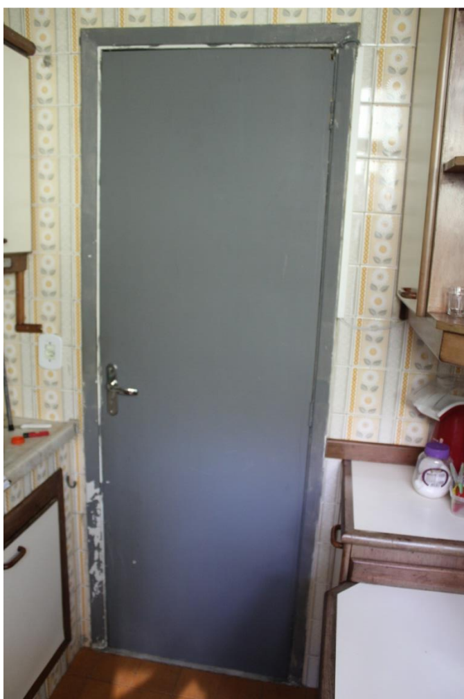
FOTO 10: Vista da porta da cozinha sem sistema de ventilação inferior.
