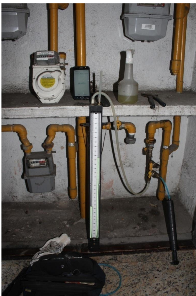
FOTO 14: Início do teste de estanqueidade com pressão de 220 mmCA.
