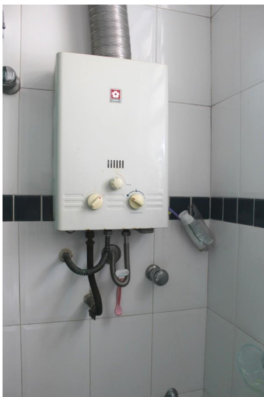
FOTO 2: Vista do aquecedor modelo SH-0504, fabricante Sakura com capacidade de 8 l/min.
