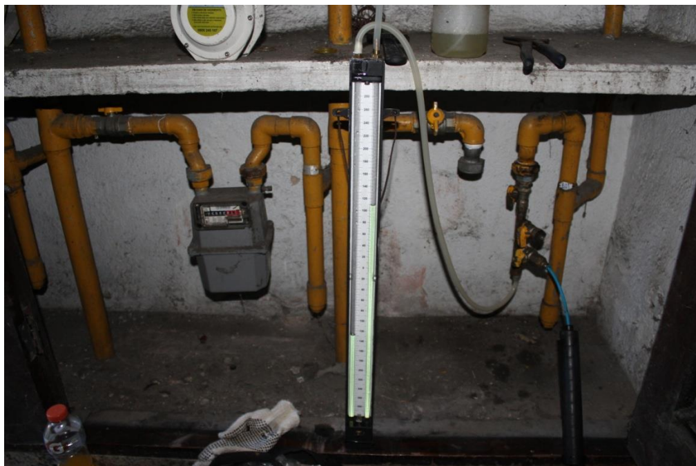
FOTO 13: Início do teste de estanqueidade com pressão de 220 mmCA.
