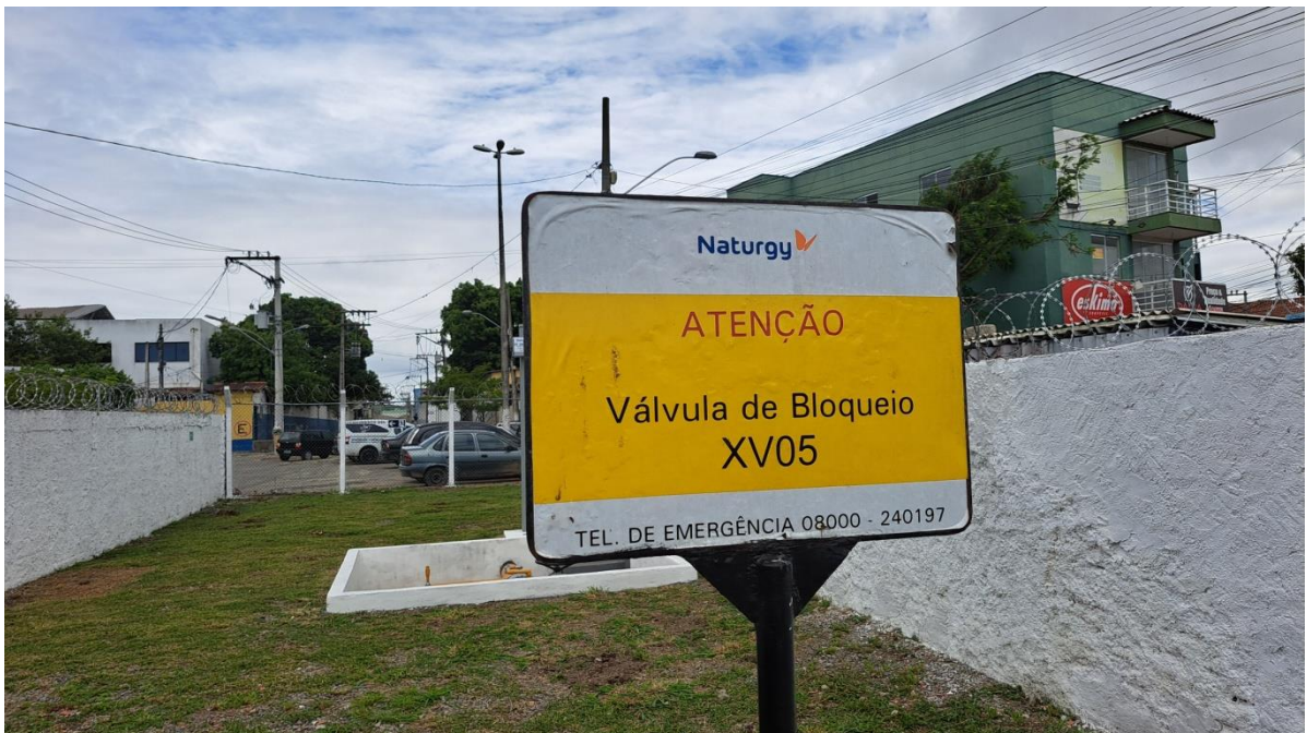
Foto 2: Placa de identificação da estação
