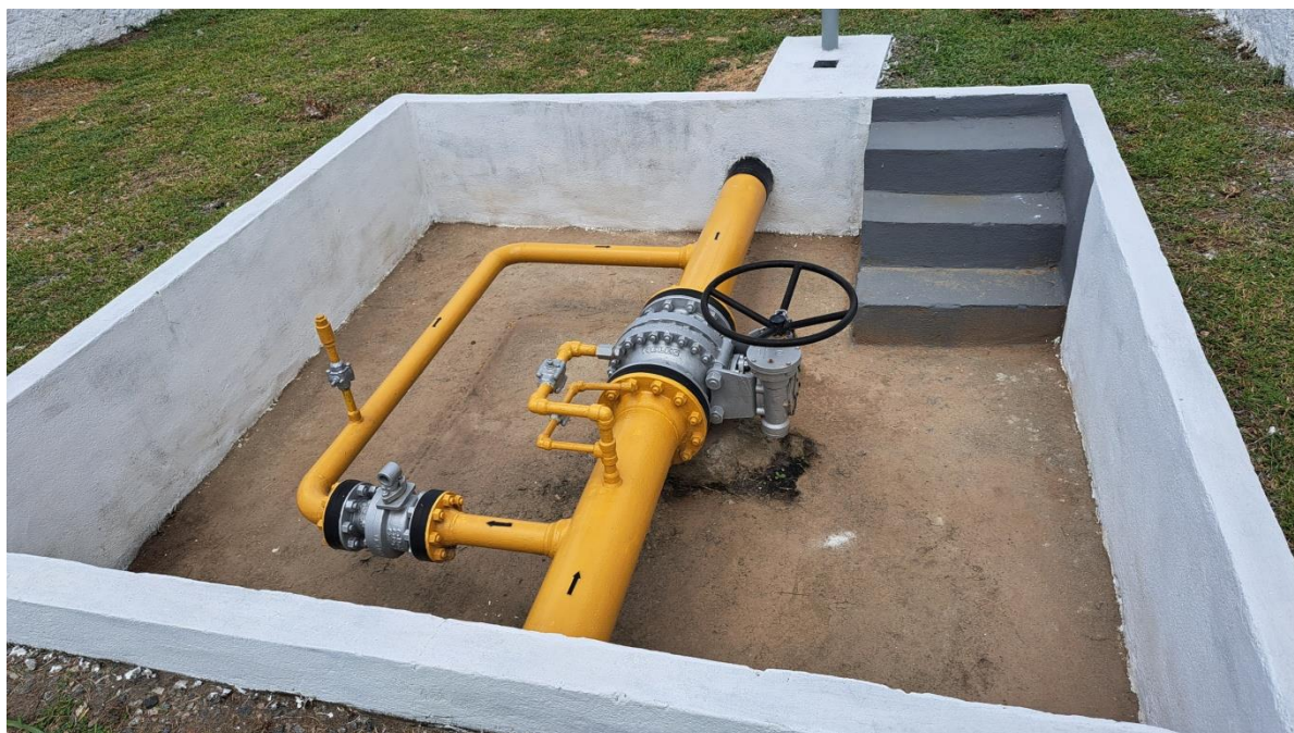
Foto 4: Detalhe acesso a válvula XV-05
