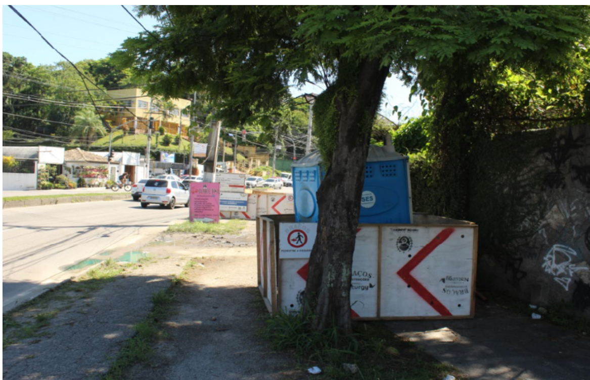
Foto 2: Sinalização no ponto de fechamento para cruzamento de pista
