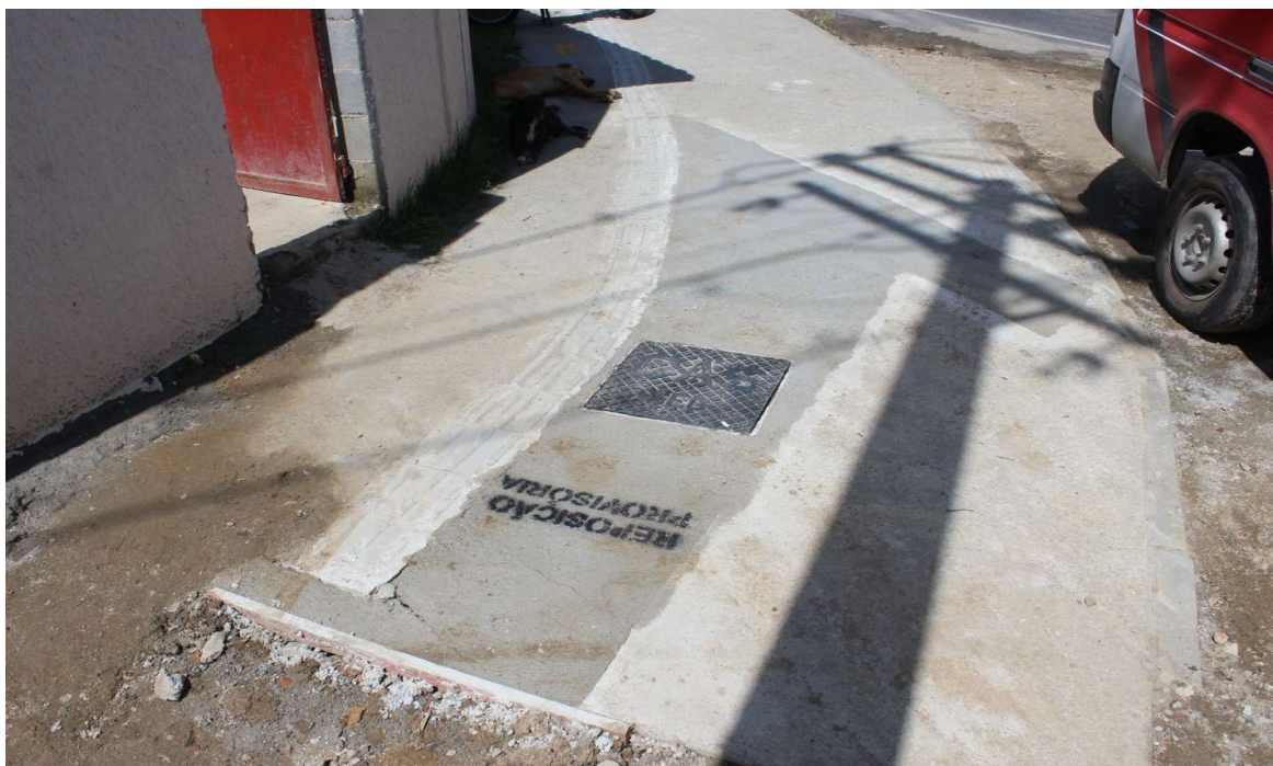
Foto 1 : Interligação da rede externa com a rede interna do conjunto habitacional, com recomposição provisória
