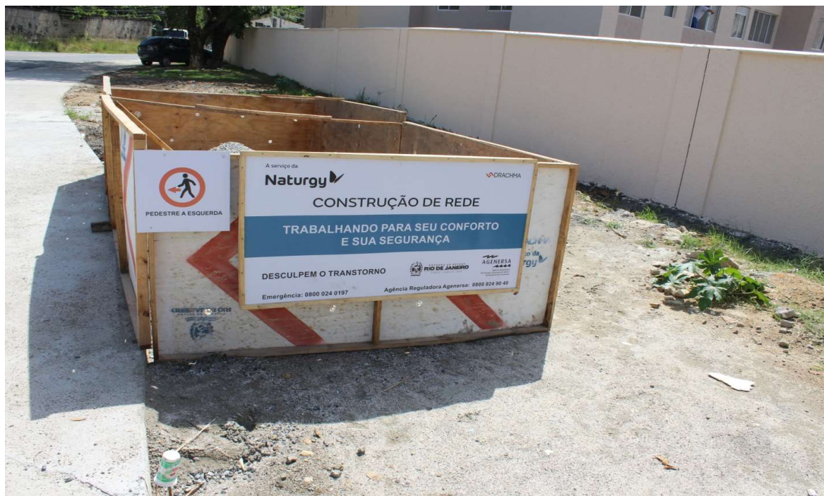
Foto 3 : Intervenção da Concessionária devidamente sinalizada.
