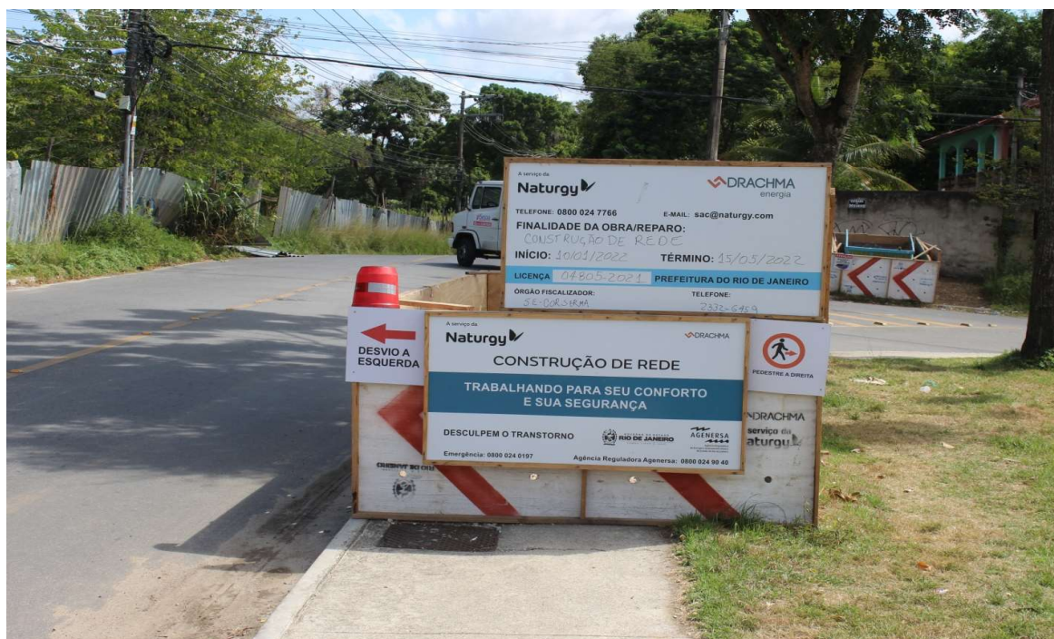
Foto 2 : Intervenção da Concessionária devidamente sinalizada.
