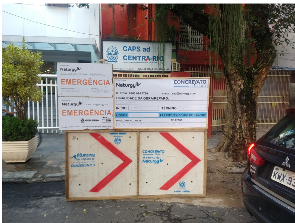
FOTO 4: Tapume, devidamente sinalizado – Rua Dona Mariana.
