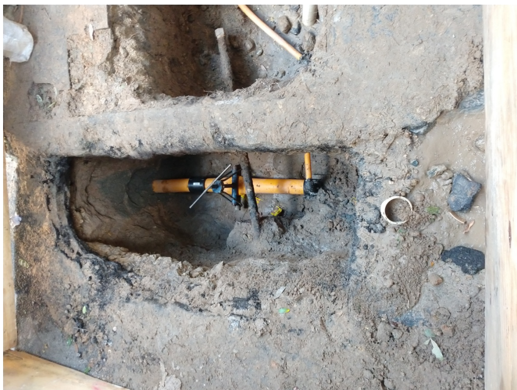
FOTO 2: Rede de gás natural pinçada para tratamento da ocorrência
