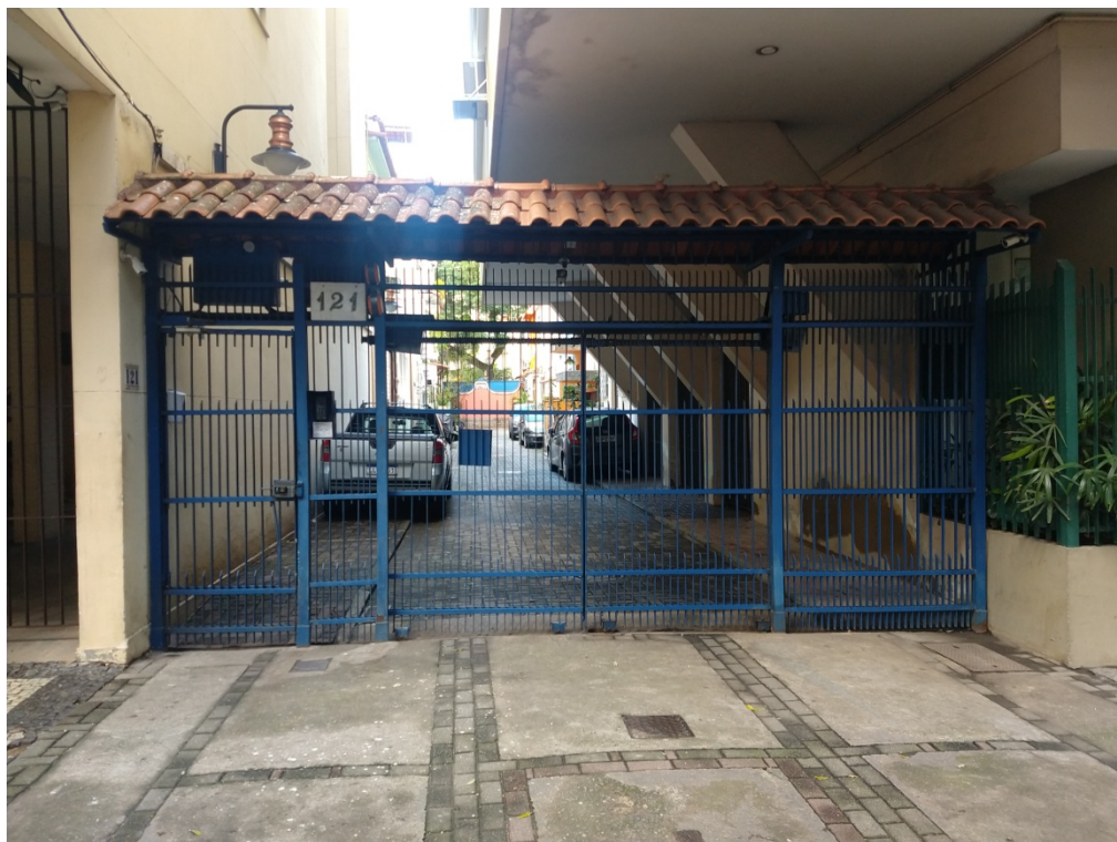
FOTO 1: Vila onde ocorreu a ligação invertida do aquecedor, localizado no nº: 121 da Rua Dona Mariana, Botafogo
