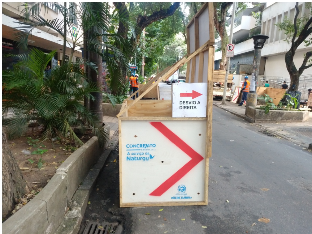
FOTO 6: Tapume, devidamente sinalizado – Rua Dona Mariana.
