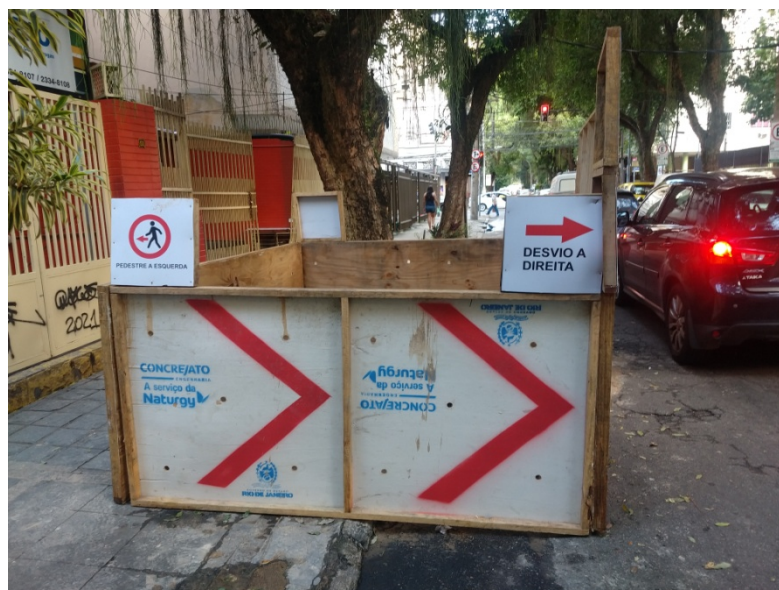
FOTO 3: Tapume, devidamente sinalizado – Rua Dona Mariana.
