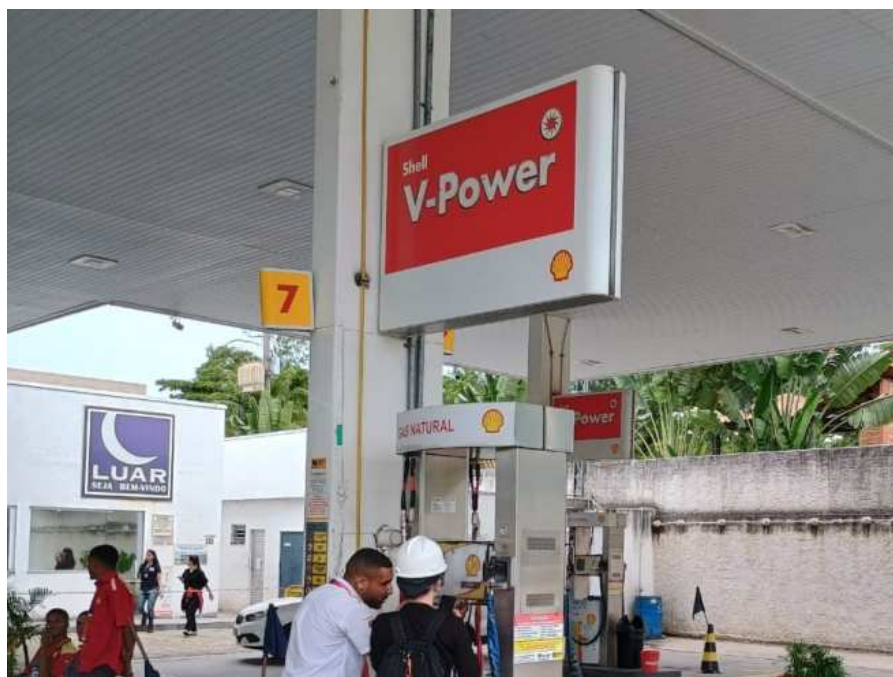
Foto 5: bombas de abastecimento de GNV do posto Luar.
