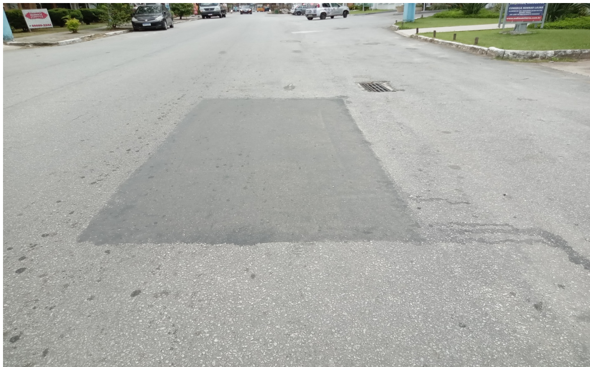
Foto 9: Recomposição asfáltica em local onde foi realizada abertura
