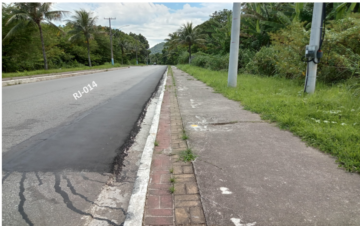
Foto 3: Recomposição da via em trecho realizado por método destrutivo
