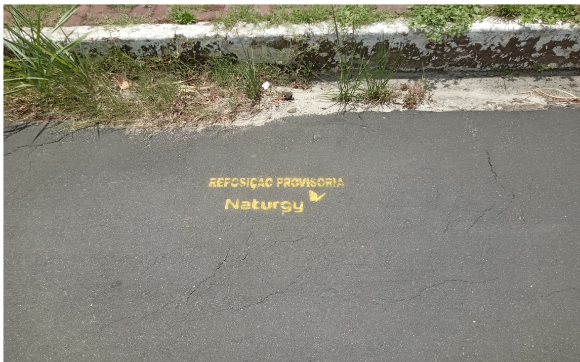
Foto 6: Recomposição provisória da via
