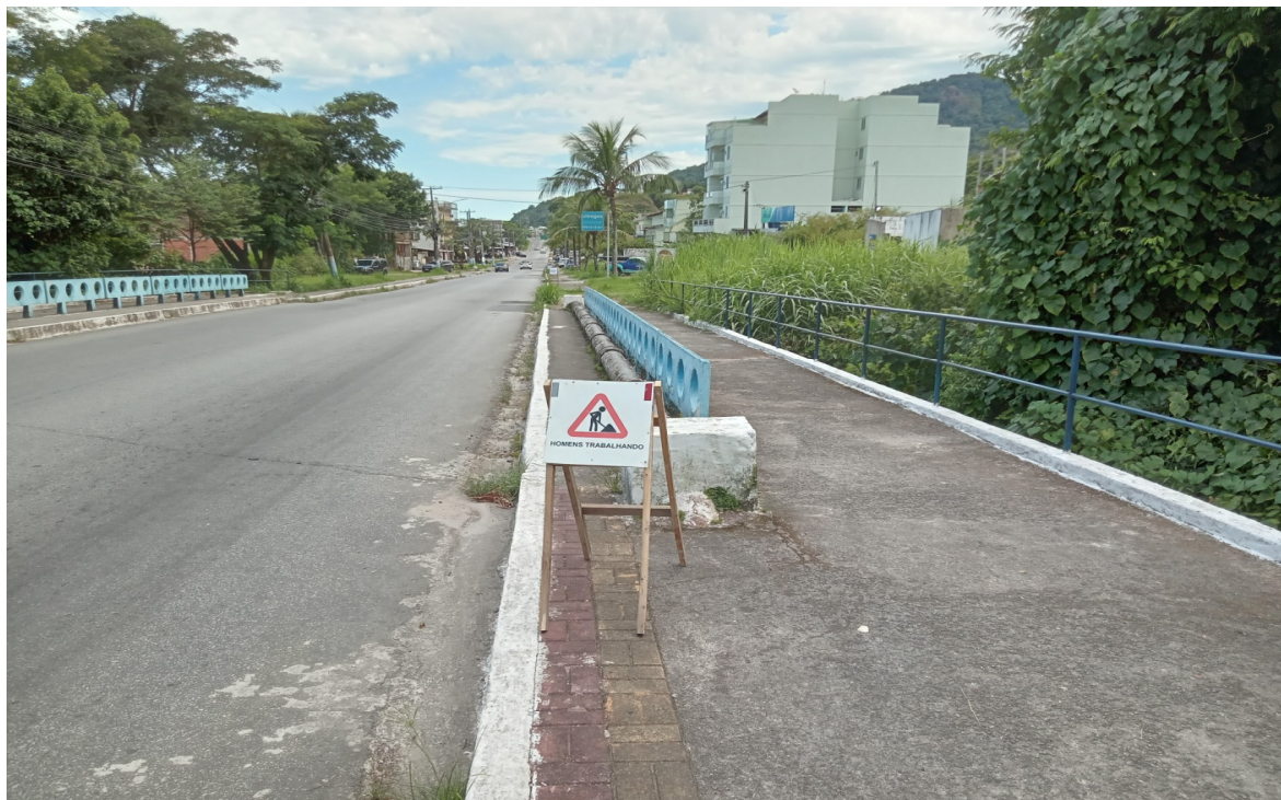
Foto 5: Local onde será realizada travessia aérea de rede de gás em aço
