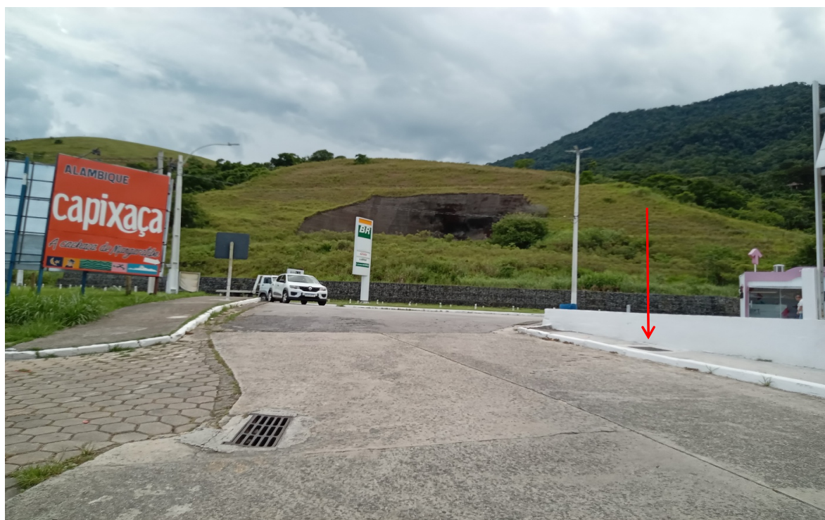
Foto 8: Válvula de ramal (previsão para abastecimento de posto de combustíveis BR)
