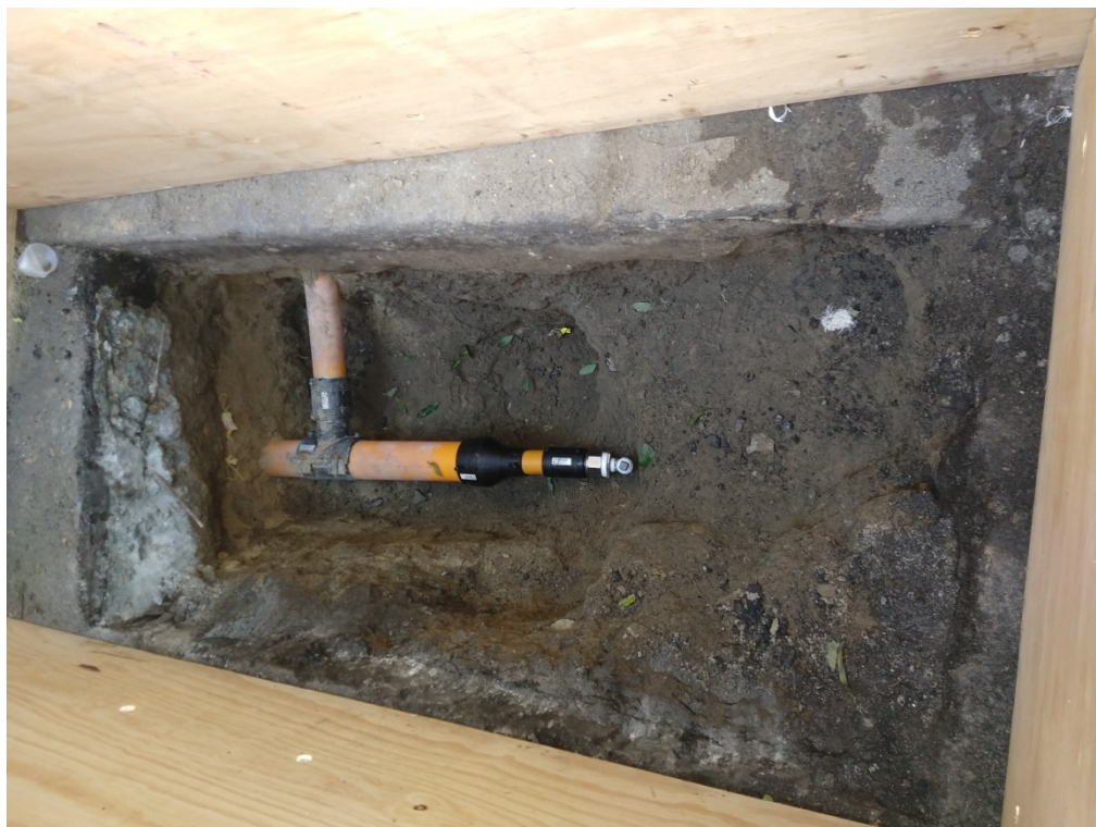
FOTO 5: Abertura para acessar a tubulação – Rua General Ribeiro da Costa.
