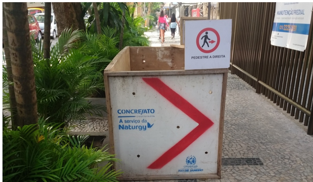
FOTO 3: Tapume em calçada, devidamente sinalizado – Rua General Ribeiro da Costa.
