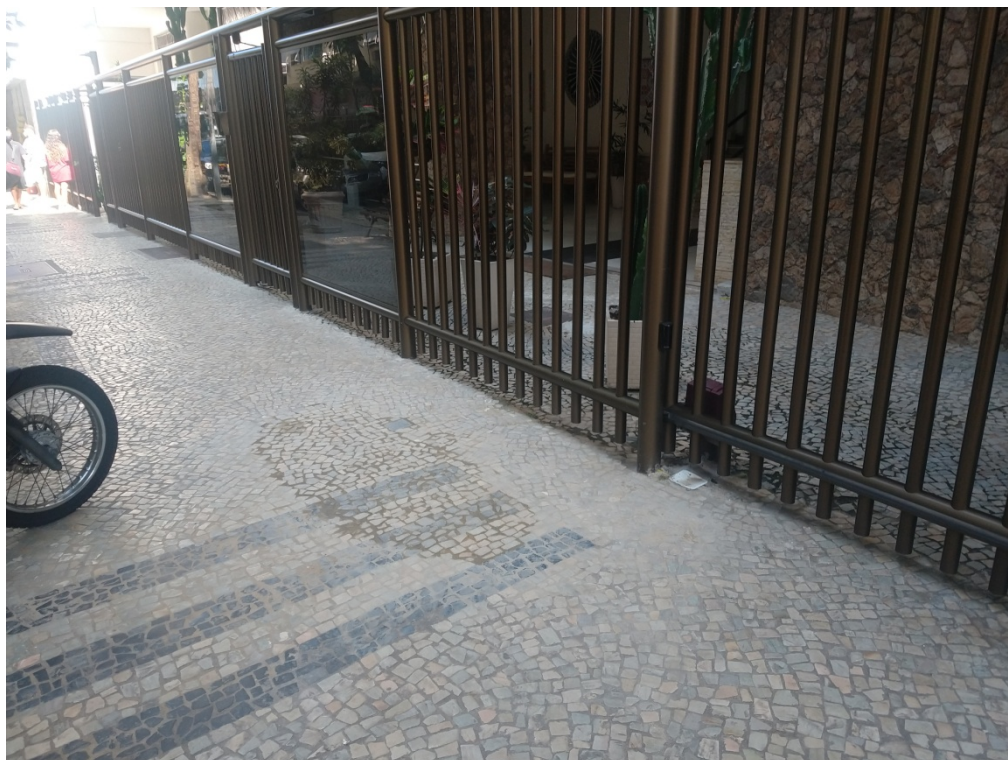
FOTO 2: Recomposição devidamente realizada em frente ao nº: 21 da Rua Anchieta, Leme
