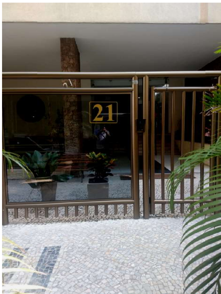
FOTO 1: Prédio onde ocorreu a ligação invertida do aquecedor, localizado no nº: 21 da Rua Anchieta, Leme
