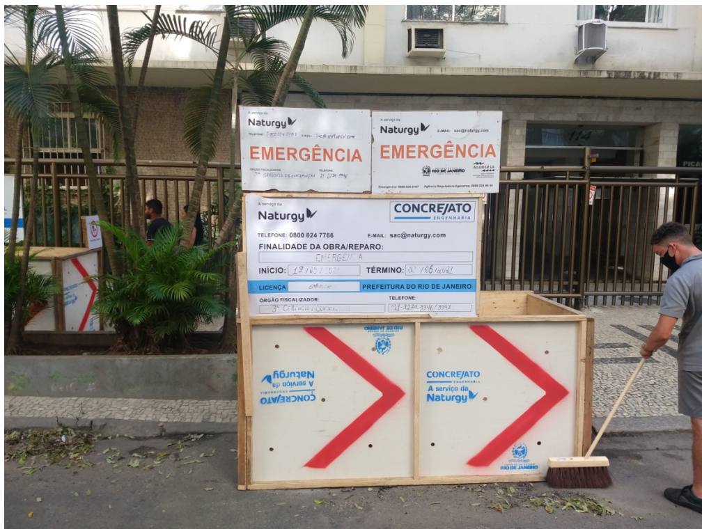
FOTO 4: Tapume em pista de rolamento, devidamente sinalizado – Rua General Ribeiro da Costa.
