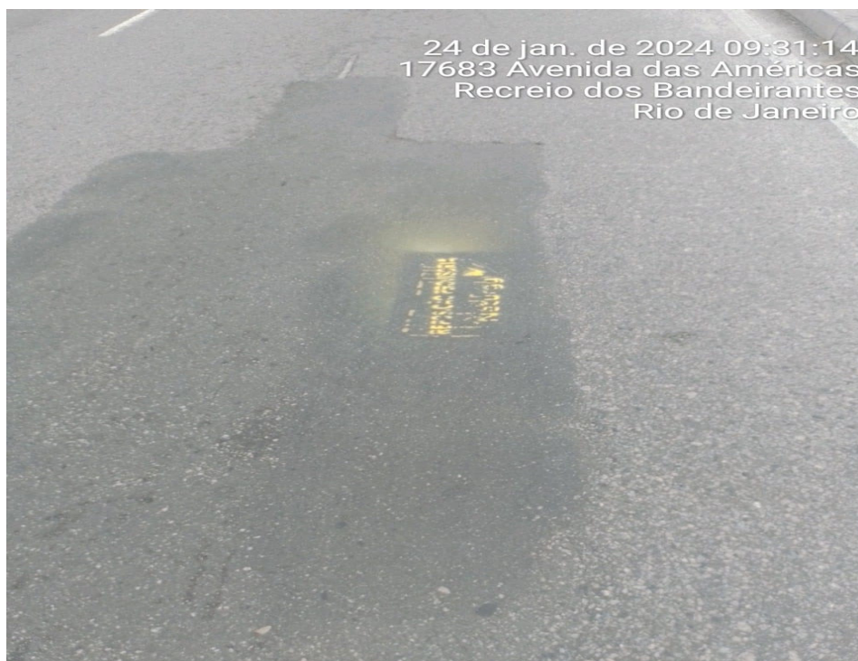
Foto 5: trecho identificado com recomposição provisória.
