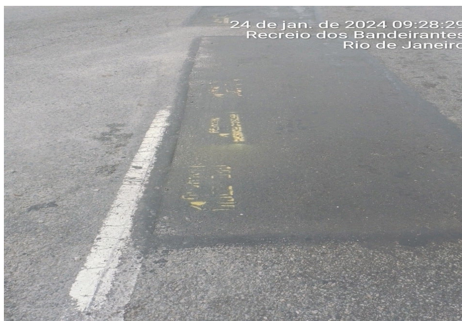
Foto 6: trecho identificado com recomposição provisória.
