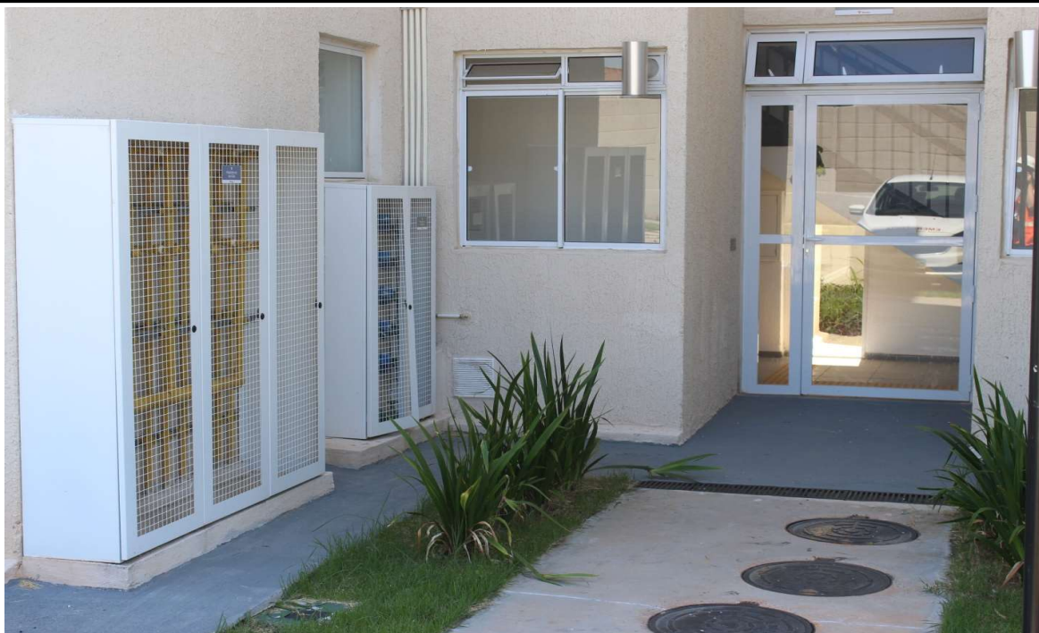
Foto 3 : Caixa de regulador e medidores
