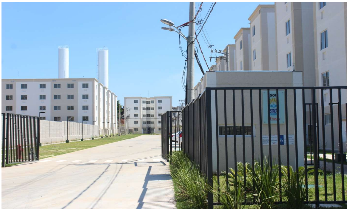
Foto 1 : Entrada do condomínio
