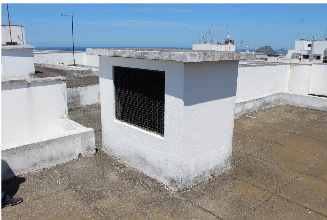
FOTO 8: Saída do prisma de ventilação no telhado do edifício
