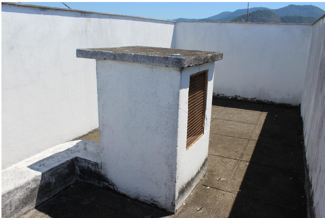
FOTO 7: Saída do prisma de ventilação no telhado do edifício
