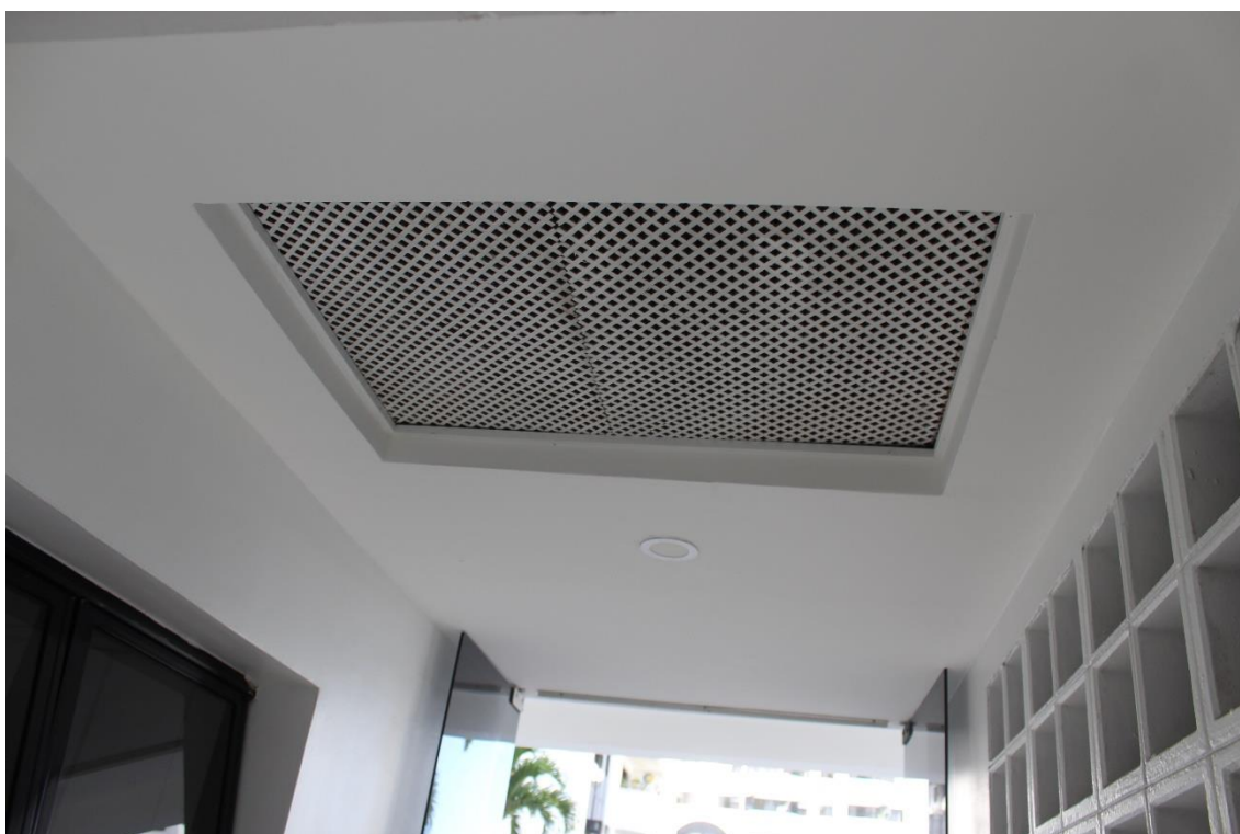
FOTO 4: Shaft das tubulações do PI do BL01.
