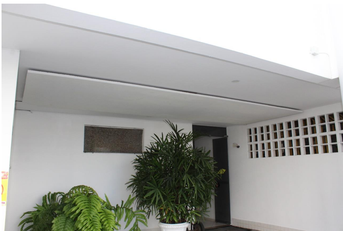
FOTO 6: Shafts das tubulações do PI BL02 e a direita da imagem a ventilação do PI do BL02.
