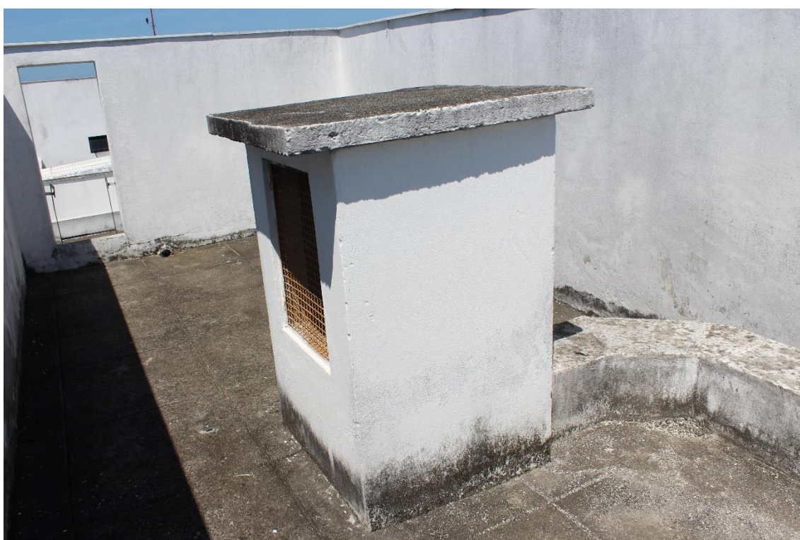
FOTO 10: Saída do prisma de ventilação no telhado do edifício
