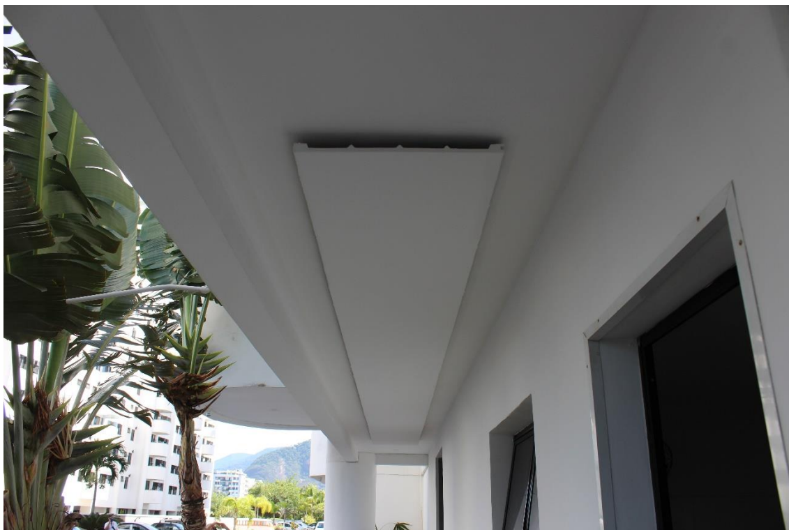
FOTO 5: Shaft das tubulações do PI do BL01.
