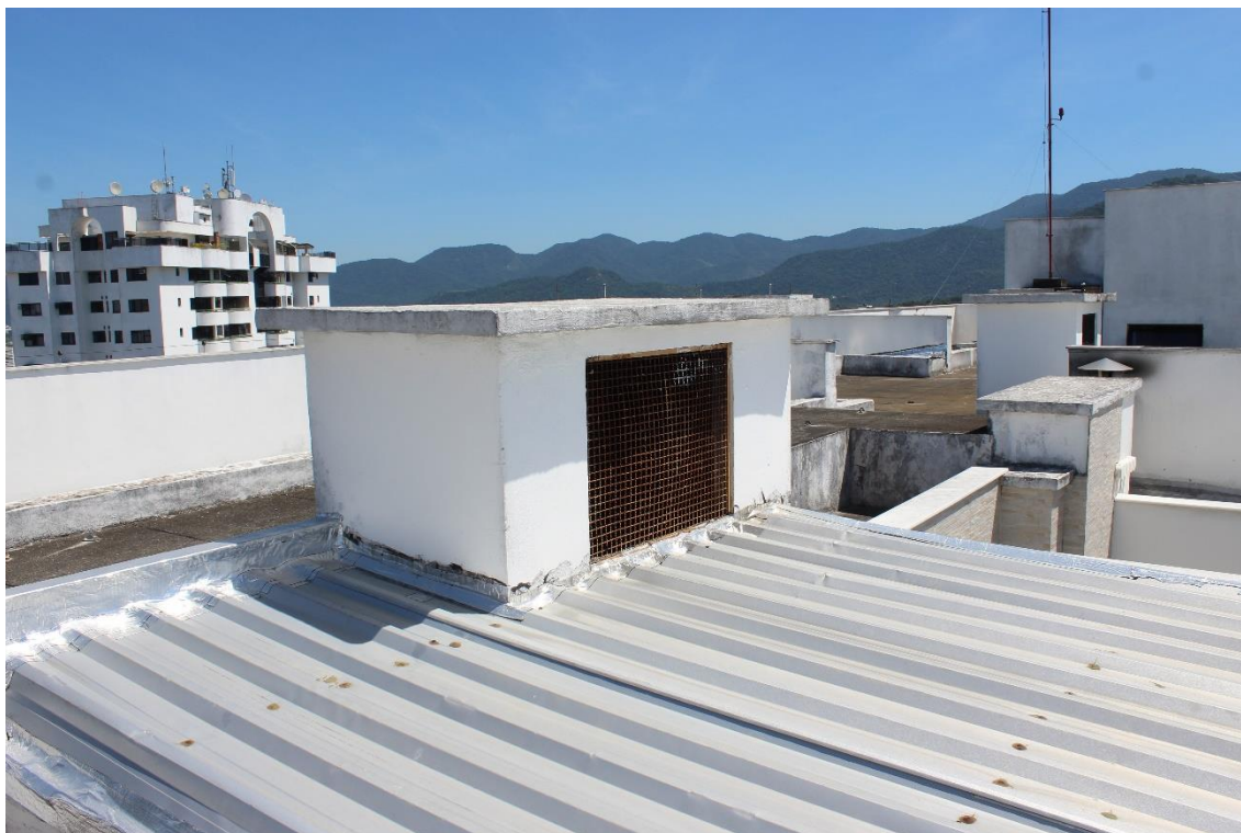
FOTO 9: Saída do prisma de ventilação no telhado do edifício
