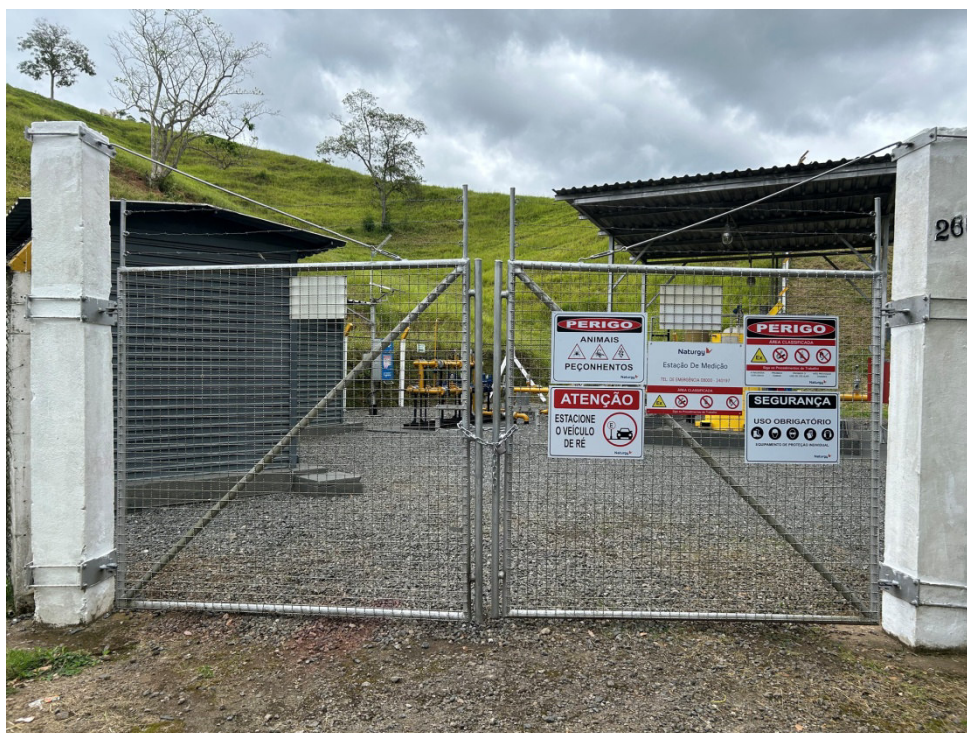
Foto 1: Identificação da estação e sinalização.
