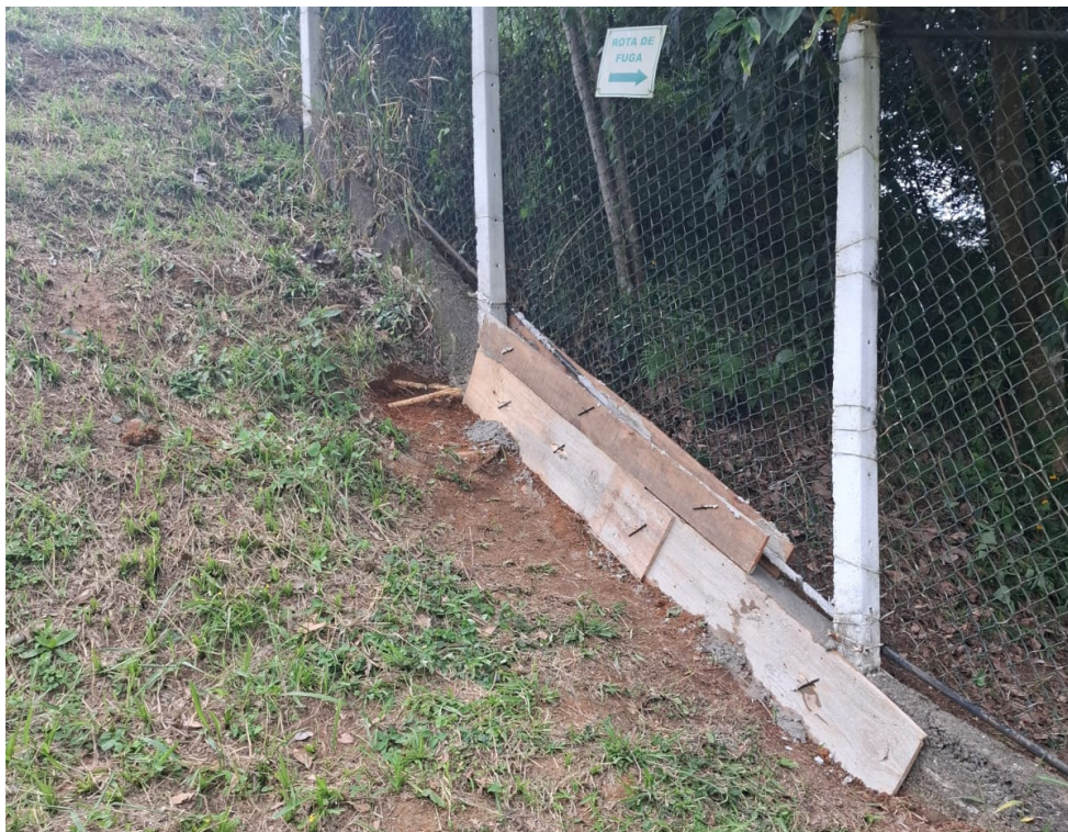
Foto 14: Abertura embaixo da cerca corrigida por meio de alvenaria.
