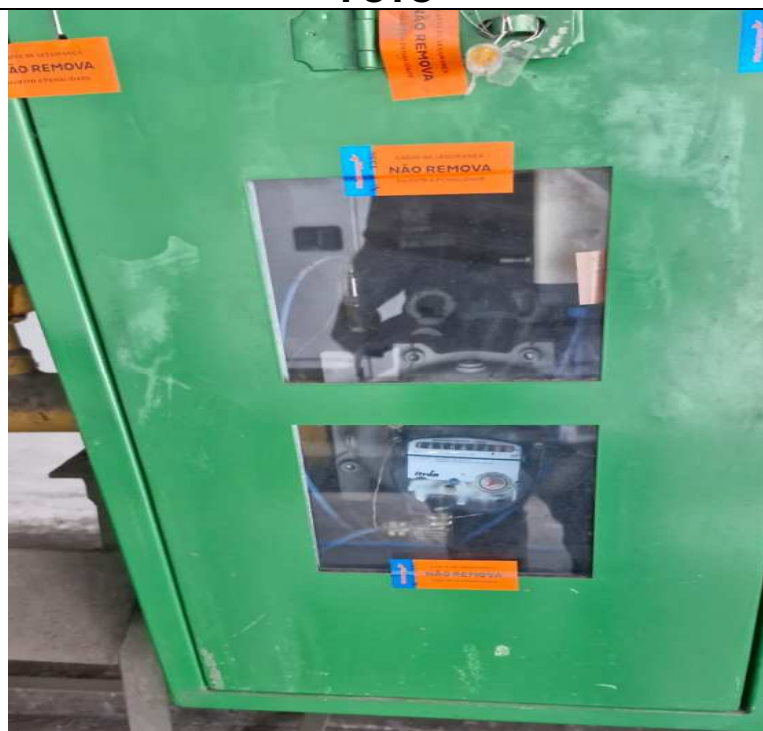
Foto 3: Detalhe da caixa de proteção do medidor no Posto Guerreiros de Caxias, com lacres de arame e adesivos
