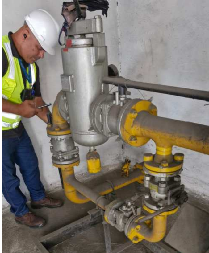
Foto 4: Funcionário da Concessionária realiza checagem dos lacres nas conexões do filtro do Posto Guerreiros de Caxias.
