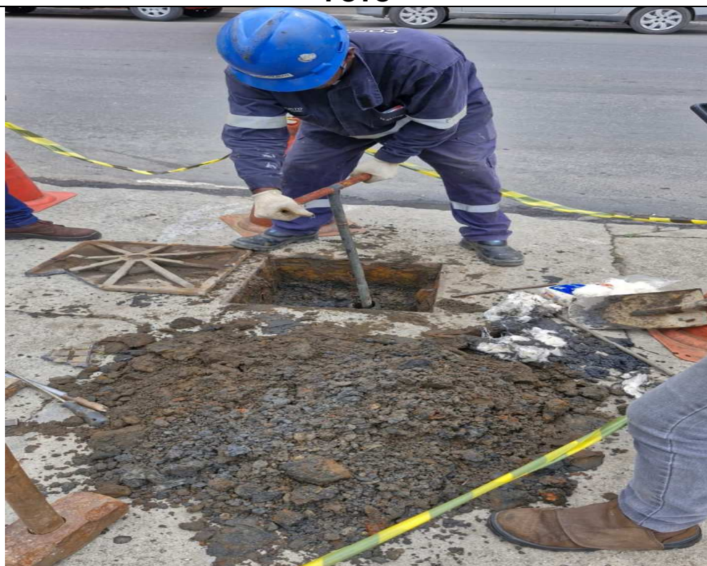
Foto 7: Técnico da Concrejato realiza fechamento do ramal do Posto Guerreiros de Caxias.
