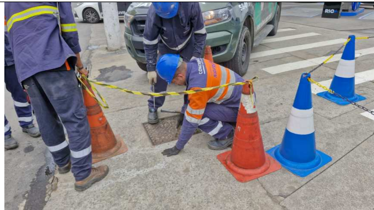
Foto 6: Técnicos da Concessionária e da Concrejato abrindo ramal do Posto Guerreiros de Caxias para exposição e registro.
