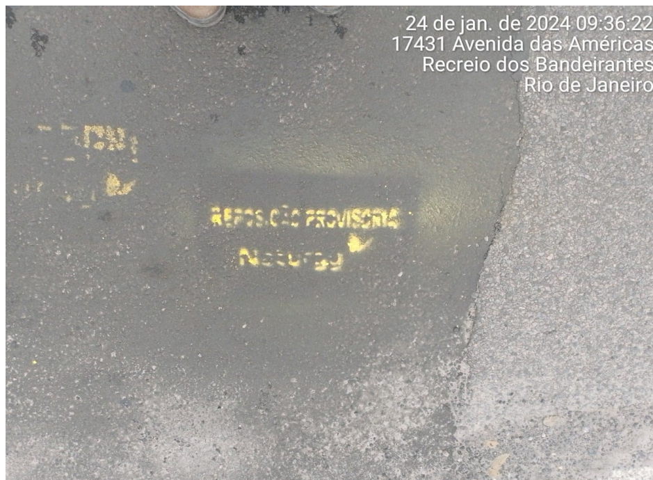
Foto 7: Recomposição provisória após identificação.
