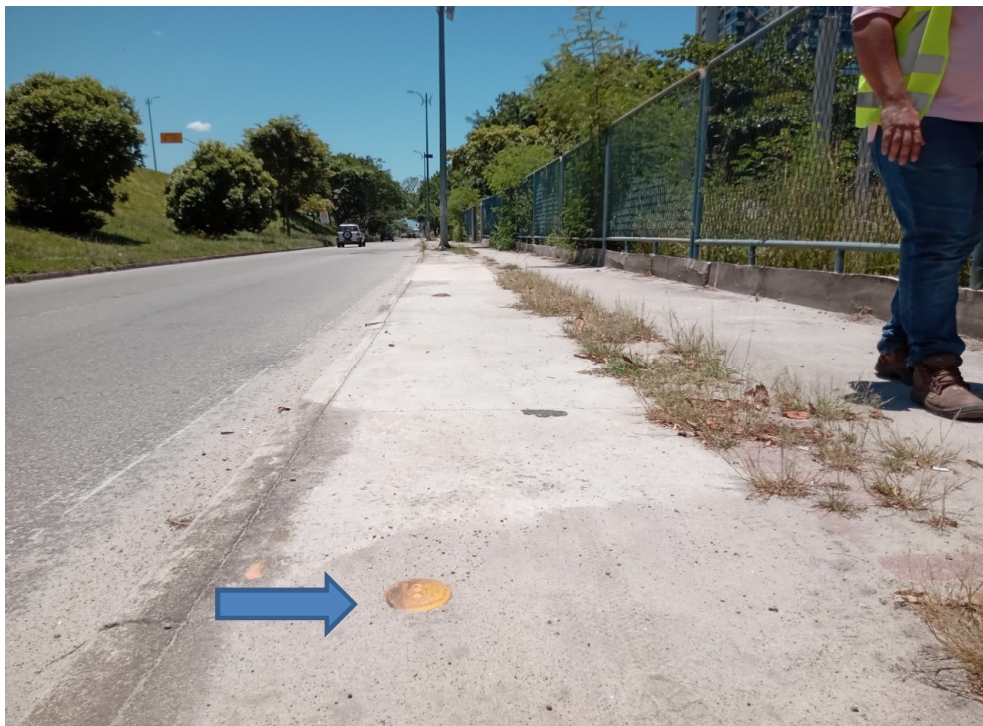
Foto 5: rede assentada no passeio e identificada com marco plano.
