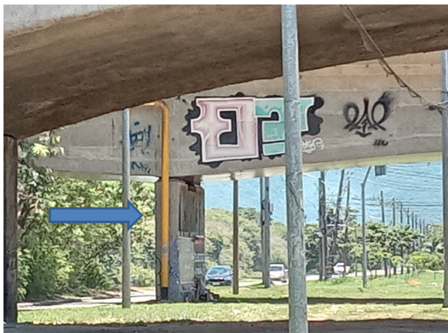
Foto 2: rede oriunda da região de Guaratiba para interligação no ponto de partida da obra.
