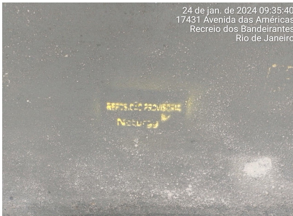
Foto 8: Recomposição provisória após identificação.
