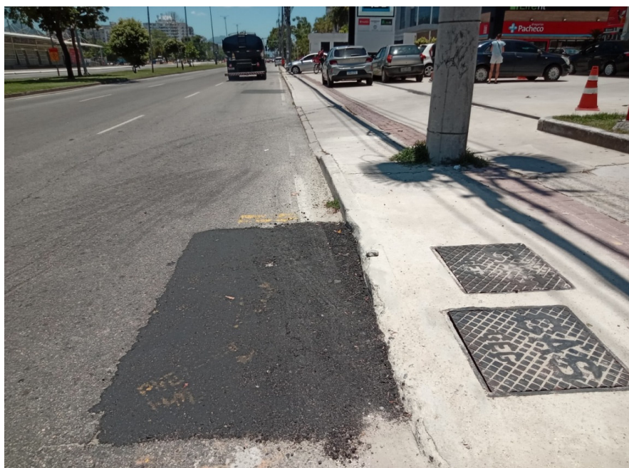
Foto 6: trecho com recomposição provisória sem identificação.
