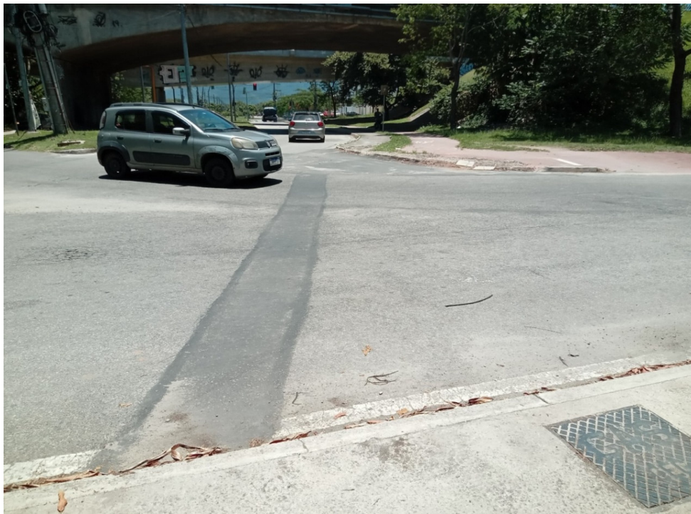
Foto 1: Ponto de partida da obra (esquina da Av. das Américas com a Estrada Vereador Alceu de Carvalho).
