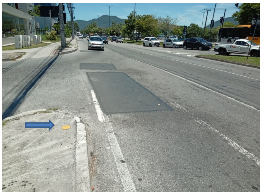
Foto 4: rede assentada no canto da pista lateral da Av. das Américas e identificada com marco plano.
