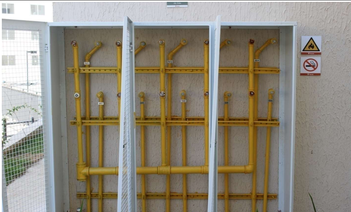
Foto 3 : Caixa de regulador e medidores
