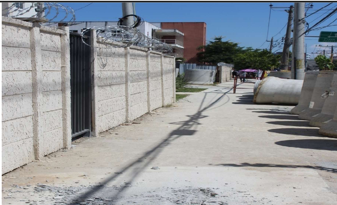
Foto 5 : Intervenção da construtora em local previamente demarcado pela concessionária
