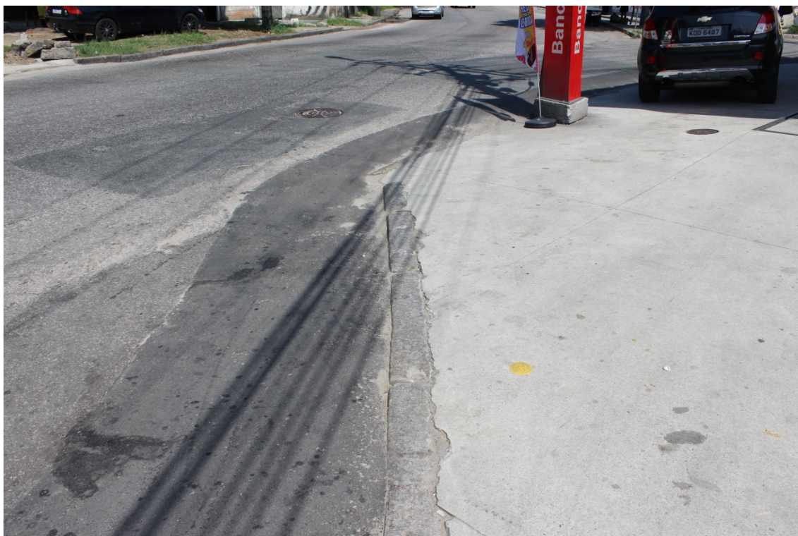
FOTO 2: Reconstituição asfáltica e marco plano indicando a presença de rede.
