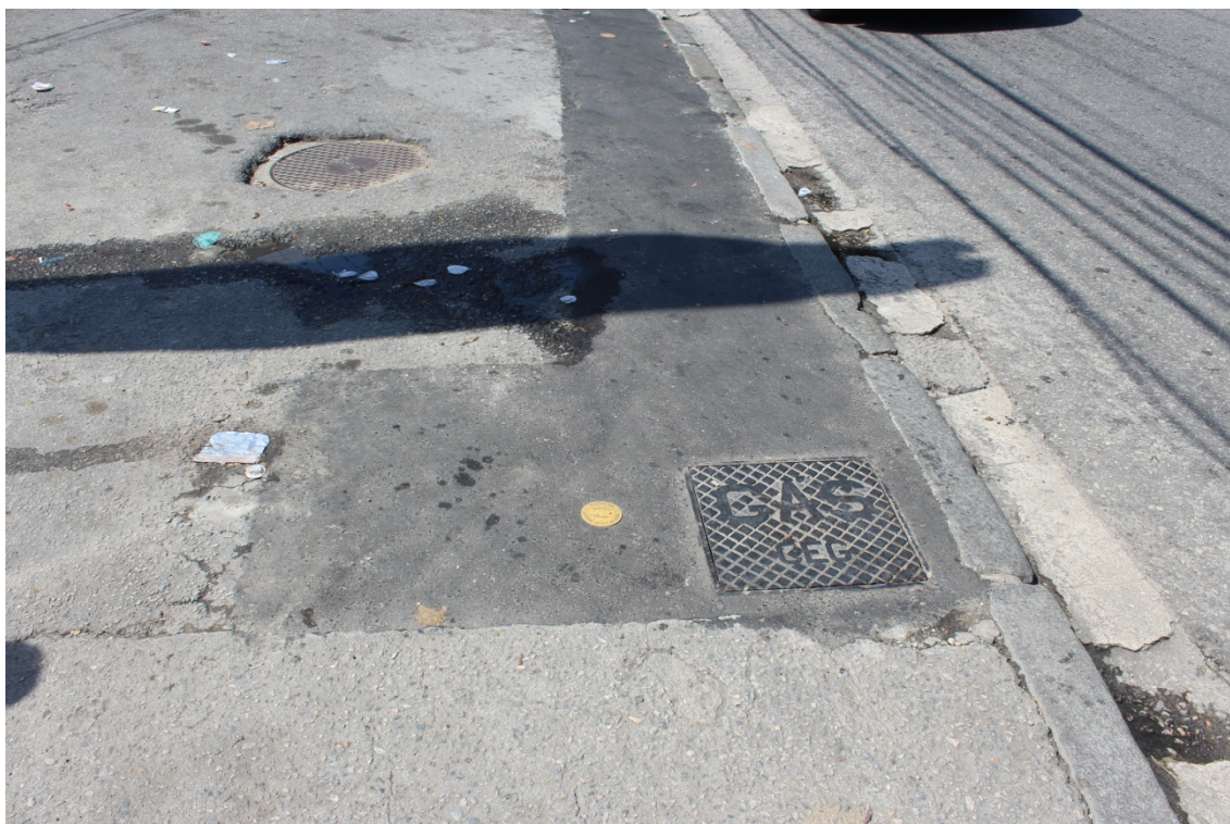
FOTO 1: Ponte de interligação da rede já existente com a nova rede – caixa com válvula de bloqueio e marco plano indicando a presença de rede.
