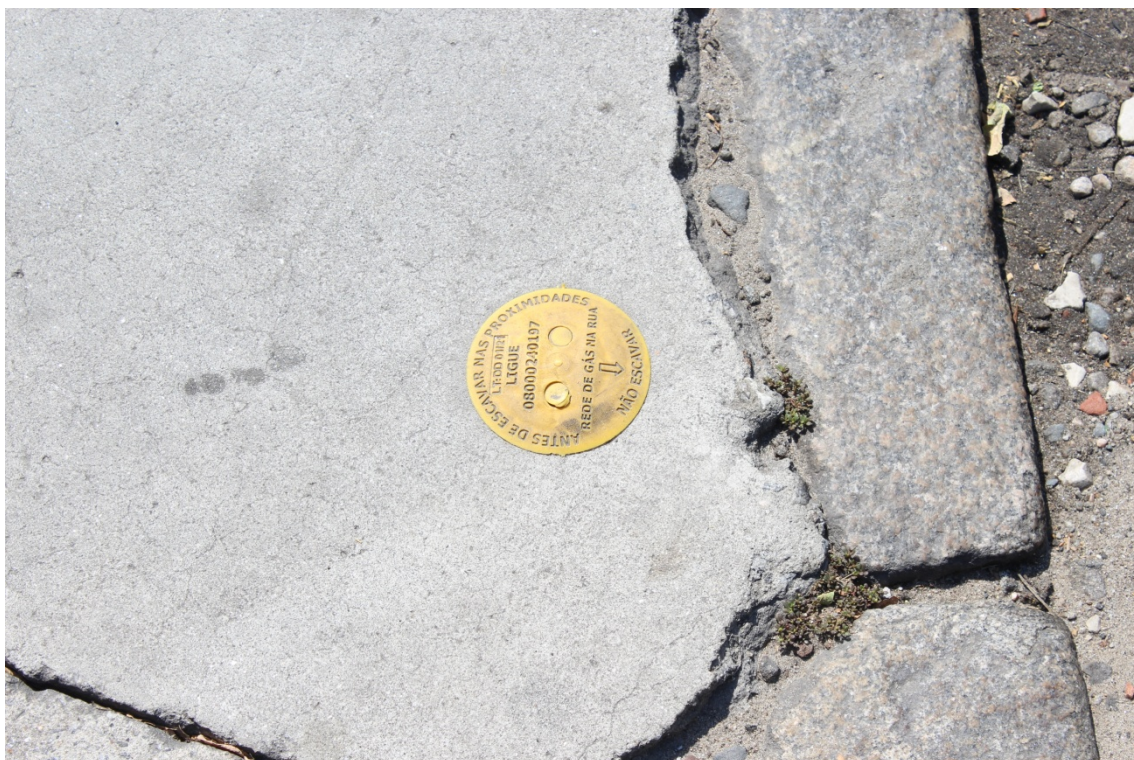
FOTO 3: Marco plano indicado a presença de rede.
