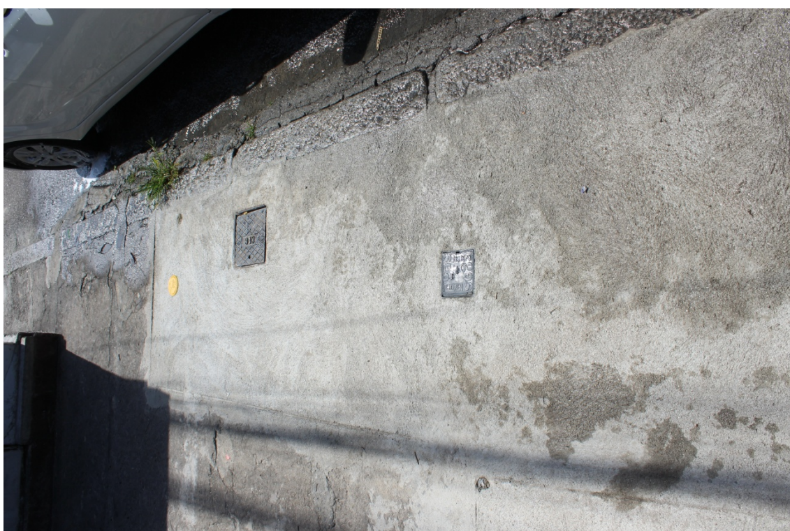
FOTO 6: Ponto de entrega ao cliente e ponto de espera para possível continuidade da rede – Duas caixas de válvulas, uma de bloqueio do cliente e outra de bloqueio da ponta da rede deixada como previsão - Marco plano indicando a presença de rede.
