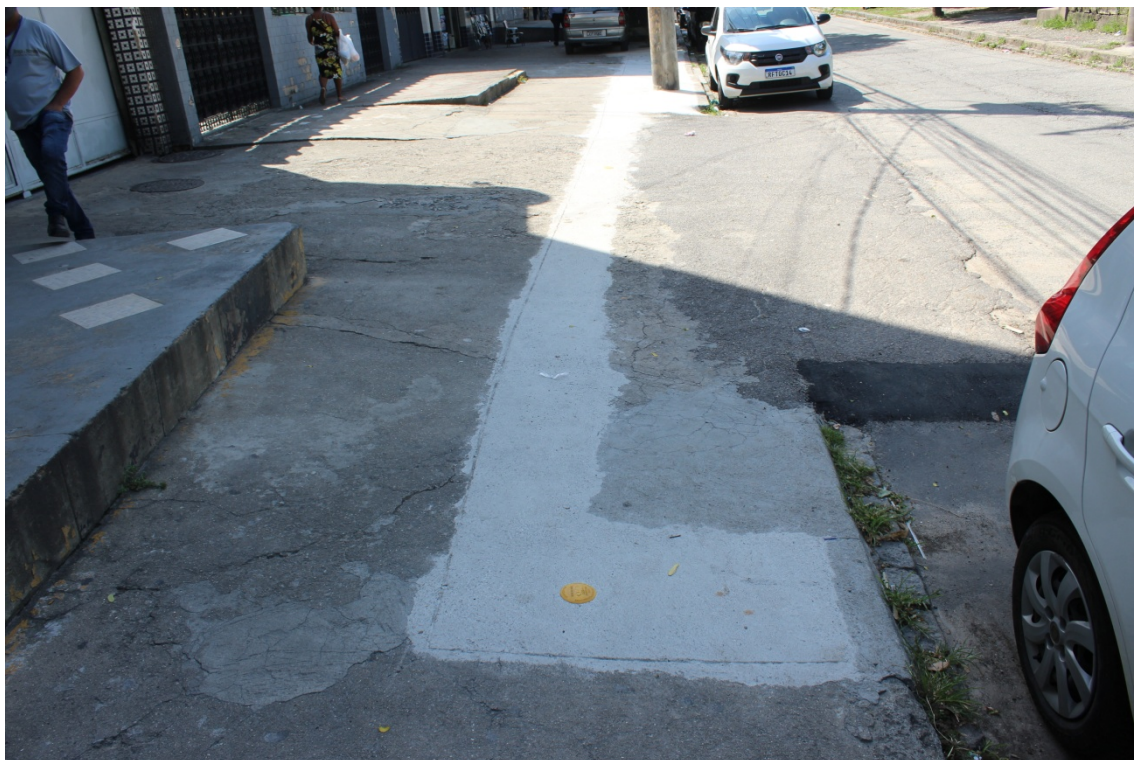
FOTO 4: Reconstituição do calçamento e marco plano indicando a presença de rede.
