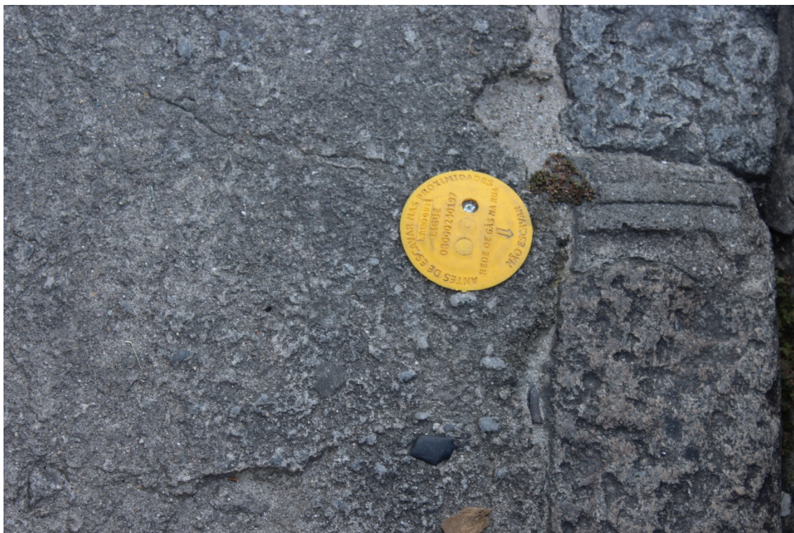
FOTO 5: Marco plano indicando a presença de rede.
