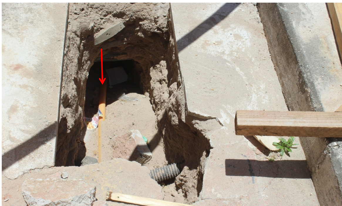
Foto 4: Tubulação de polietileno com Ø32 mm de média pressão assentada por método destrutivo.
