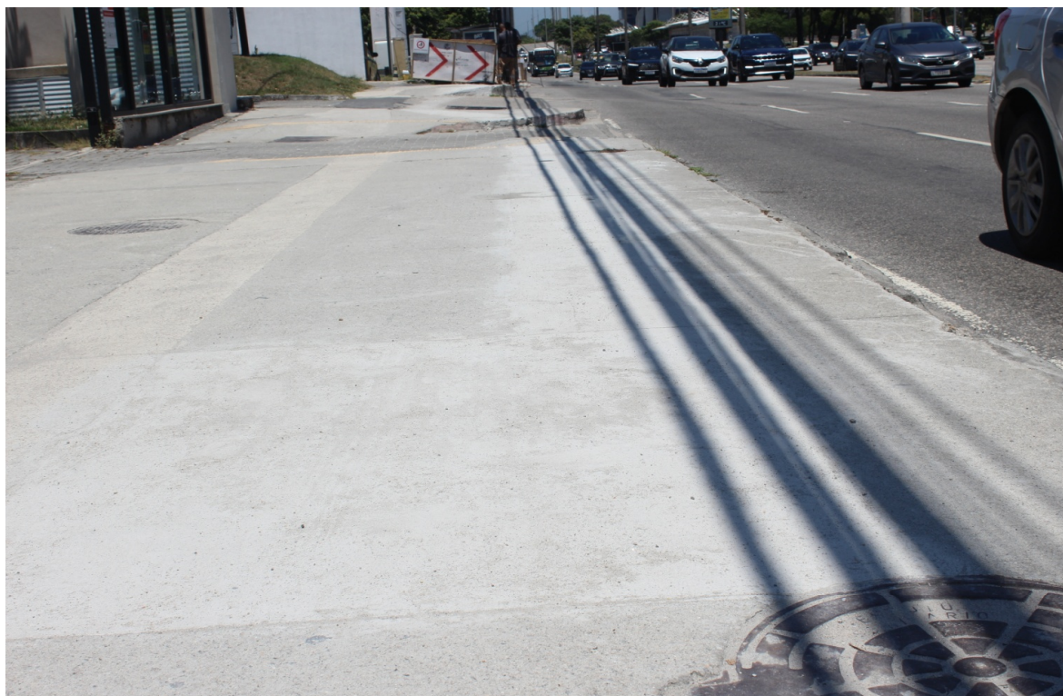
Foto 5: Tubulação já assentada e passeio recomposto.
