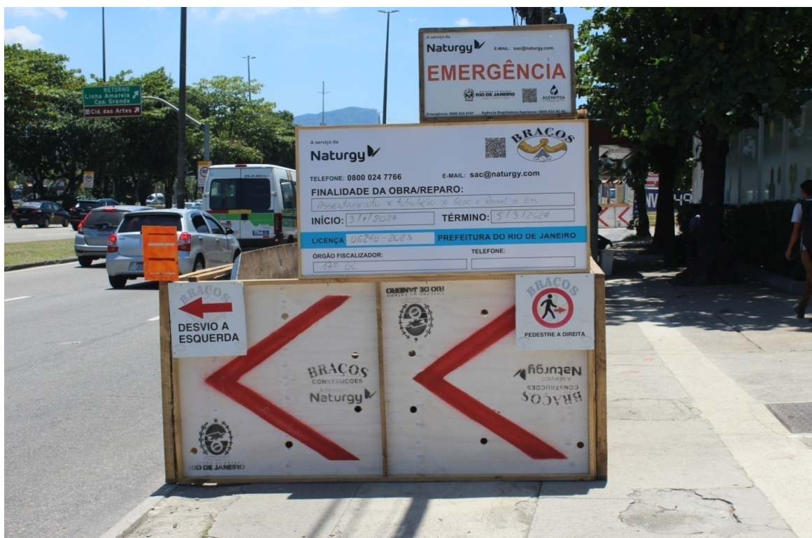
Foto 7: Identificação da obra e trechos abertos isolados com barreiras sinalizadas
