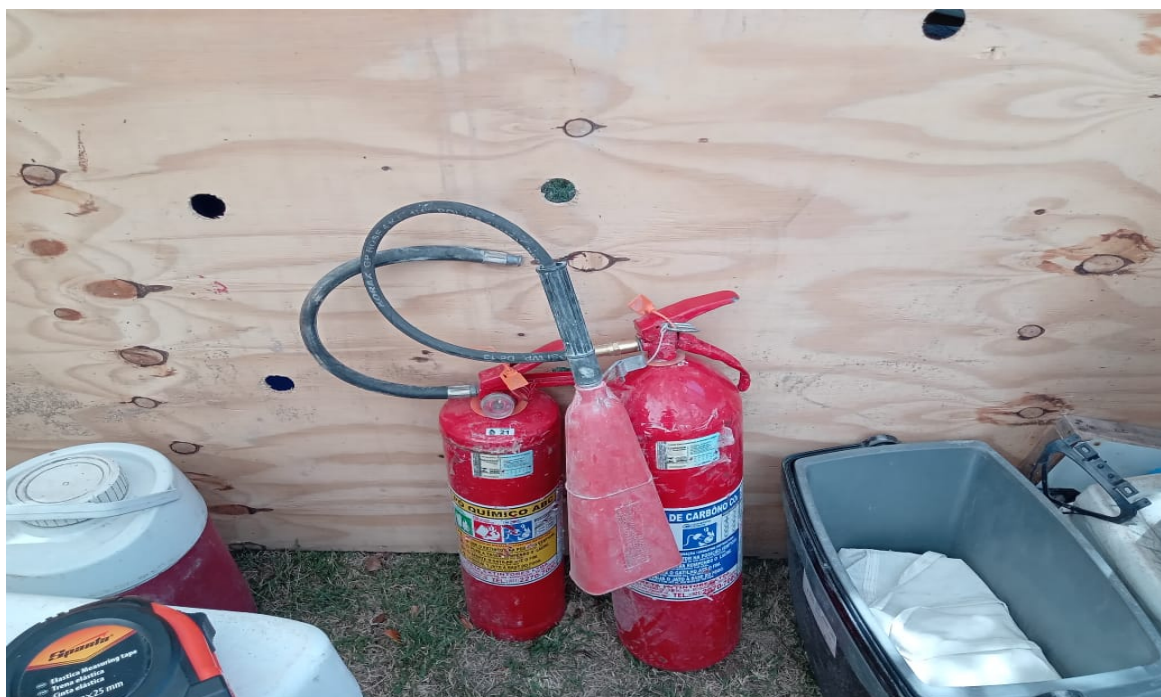
Foto 8: Extintores presentes na área de vivência
