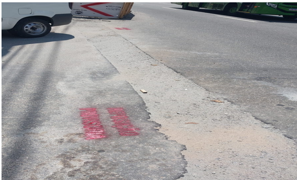
Foto 2: Recomposição provisória da via sinalizada com tinta.
