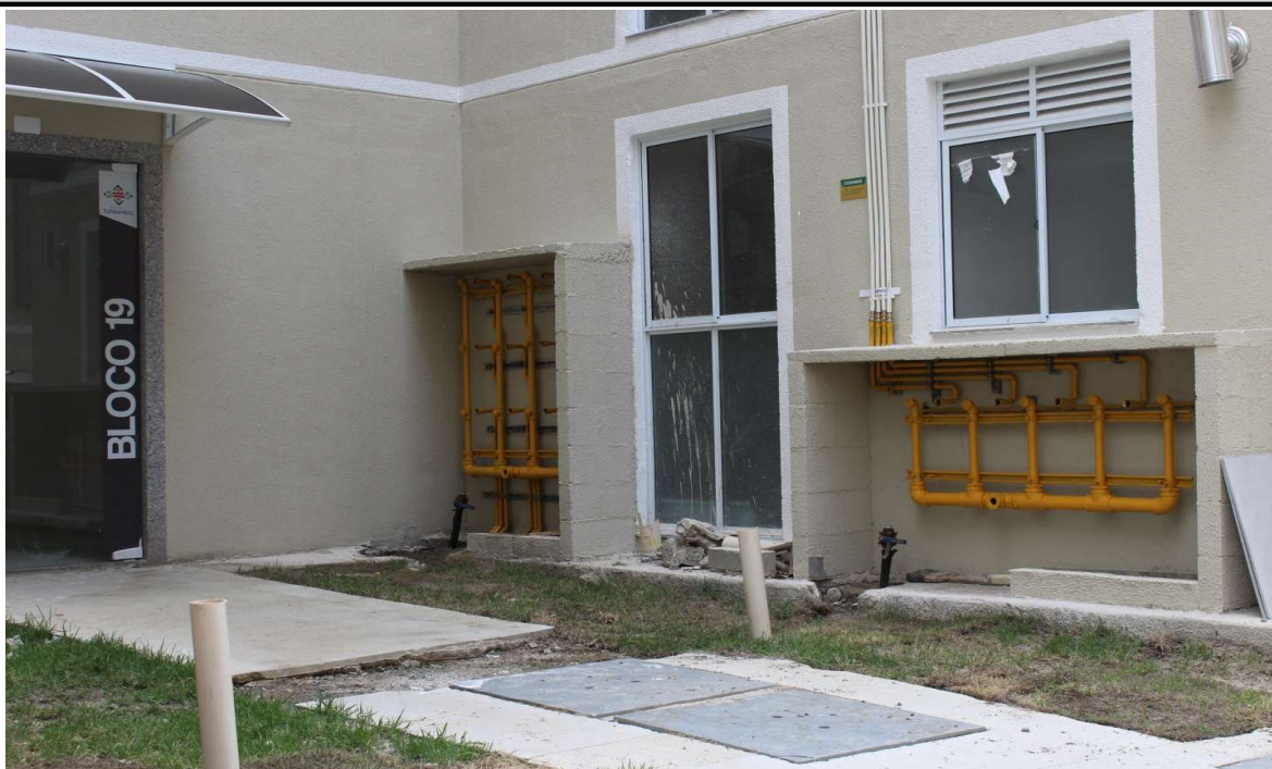
Foto 3 : Instalação da caixa de regulador e medidores
