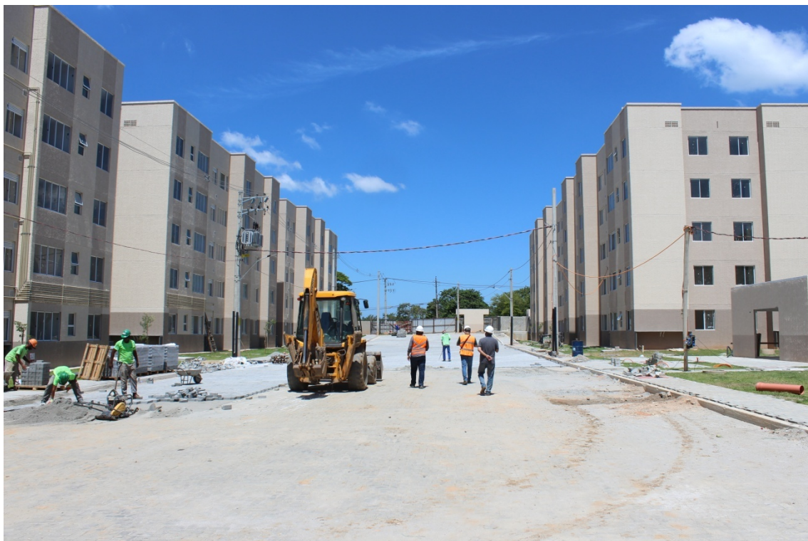
FOTO 8: Obra no interior do conjunto habitacional.
