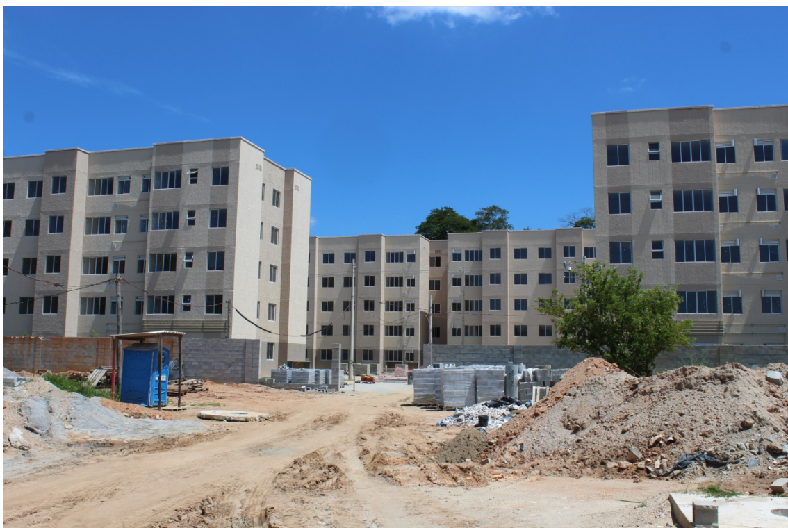
FOTO 1: Conjunto habitacional - central.
