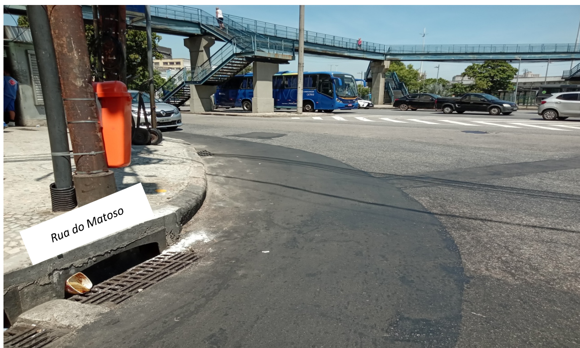
Foto 4: Recomposição da via em trecho de rede assentado - PE Ø90 mm
