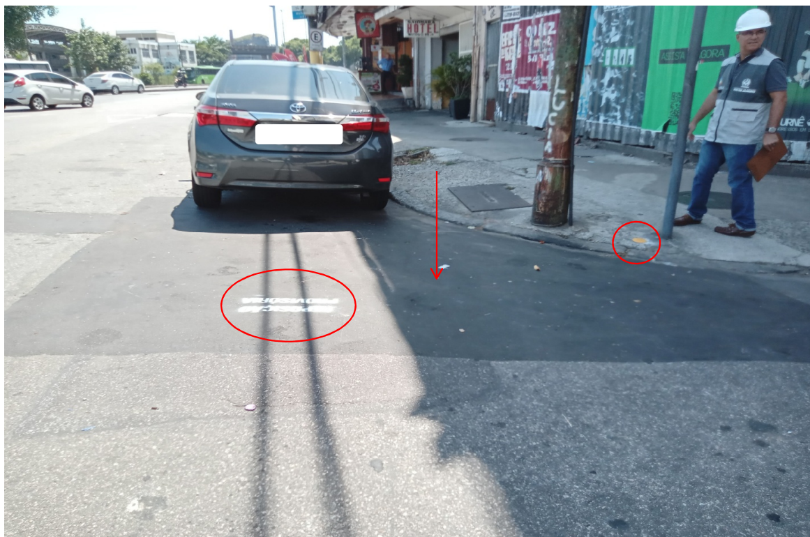
Foto 3: Ponto onde a rede se encontra capeada (recomposição provisória e marco plano)
