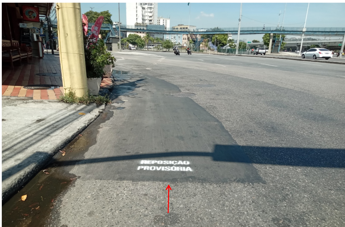
Foto 1: Ponto de início da obra de assentamento de tubulação PE Ø200 mm
