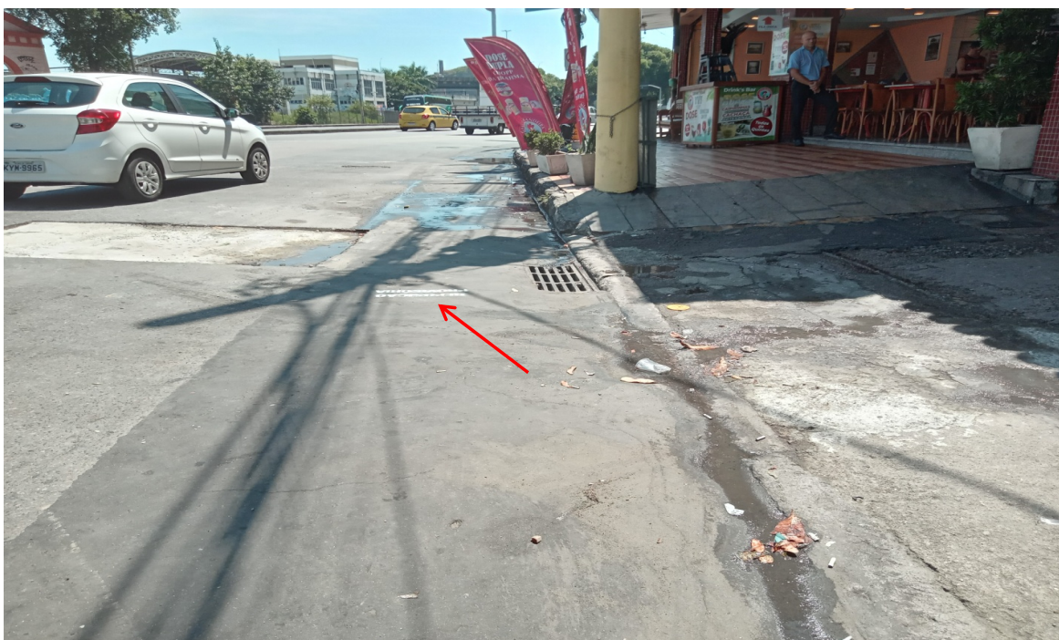
Foto 2: Trecho de obra com recomposição provisória da via
