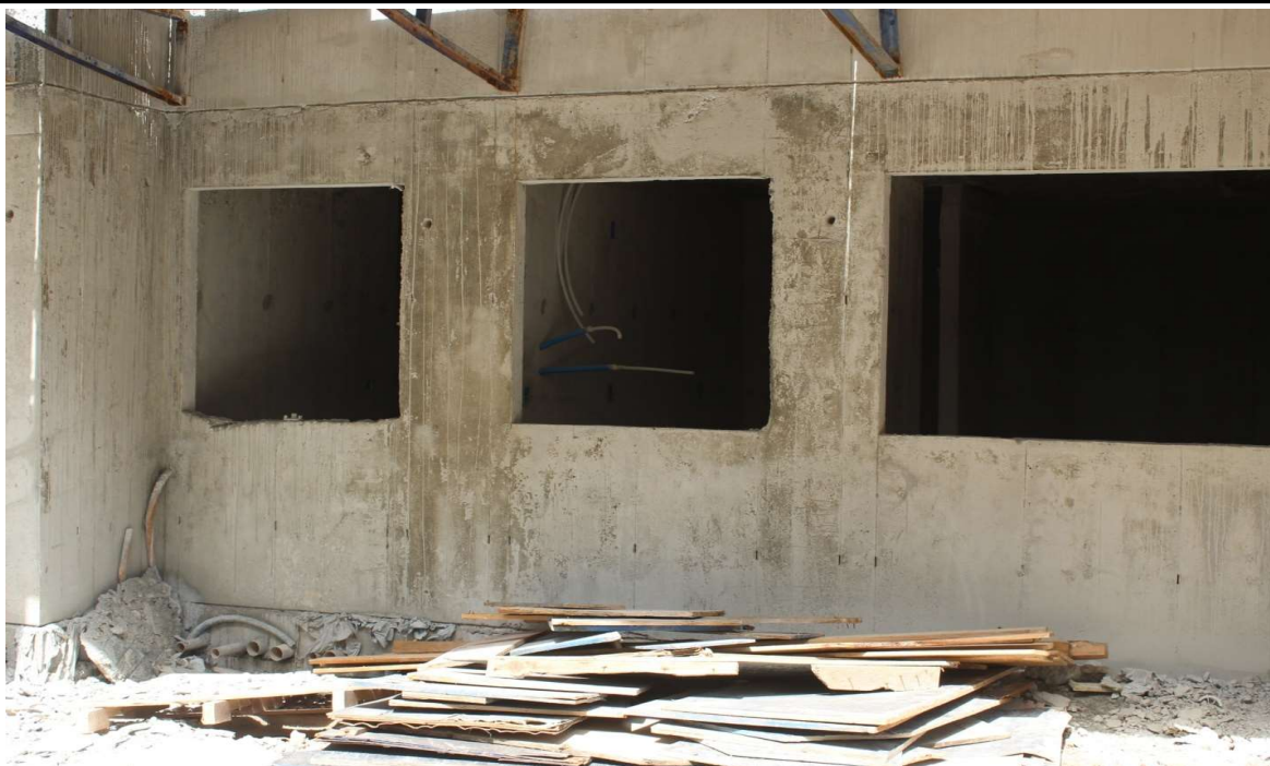
Foto 3 : Local para instalação da caixa de regulador e medidores
