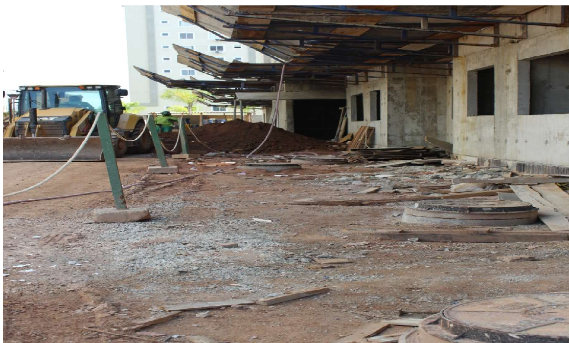
Foto 2 : Escavação em local de rede já instalada
