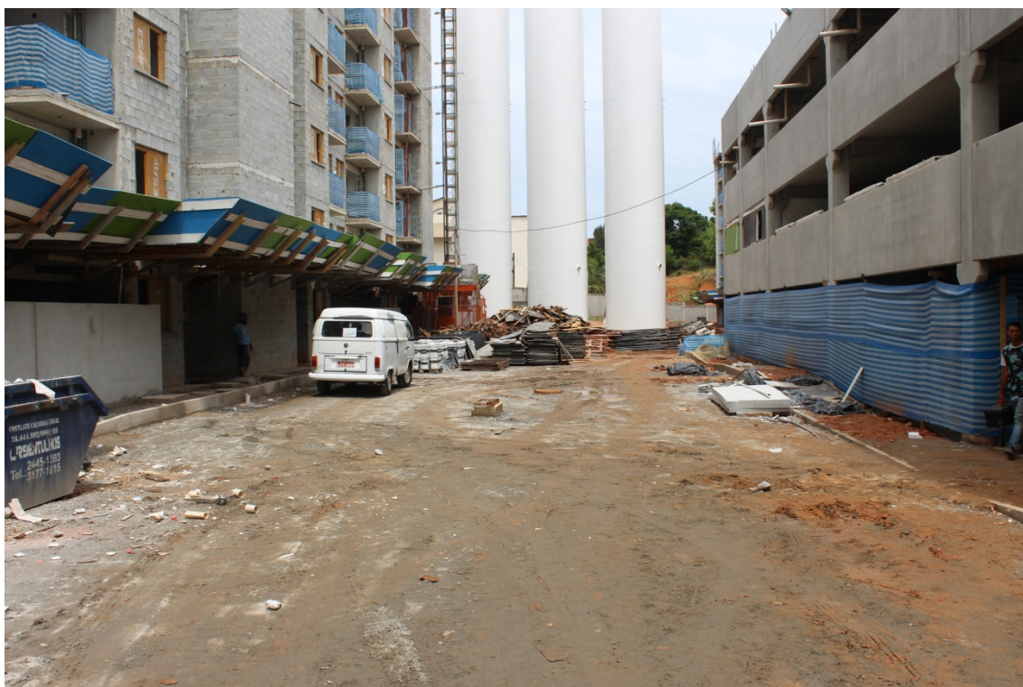
FOTO 2: Conjunto habitacional em processo de construção.
