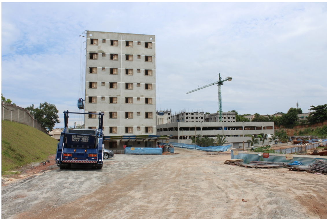
FOTO 1: Conjunto habitacional em processo de construção.
