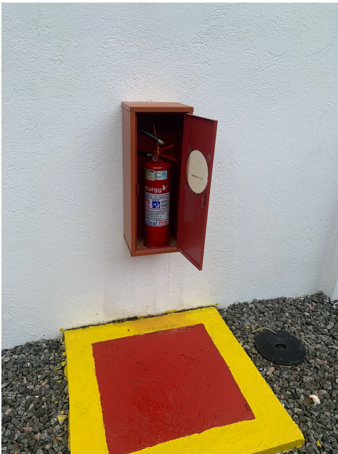
Foto 7: Extintores devidamente demarcados.
