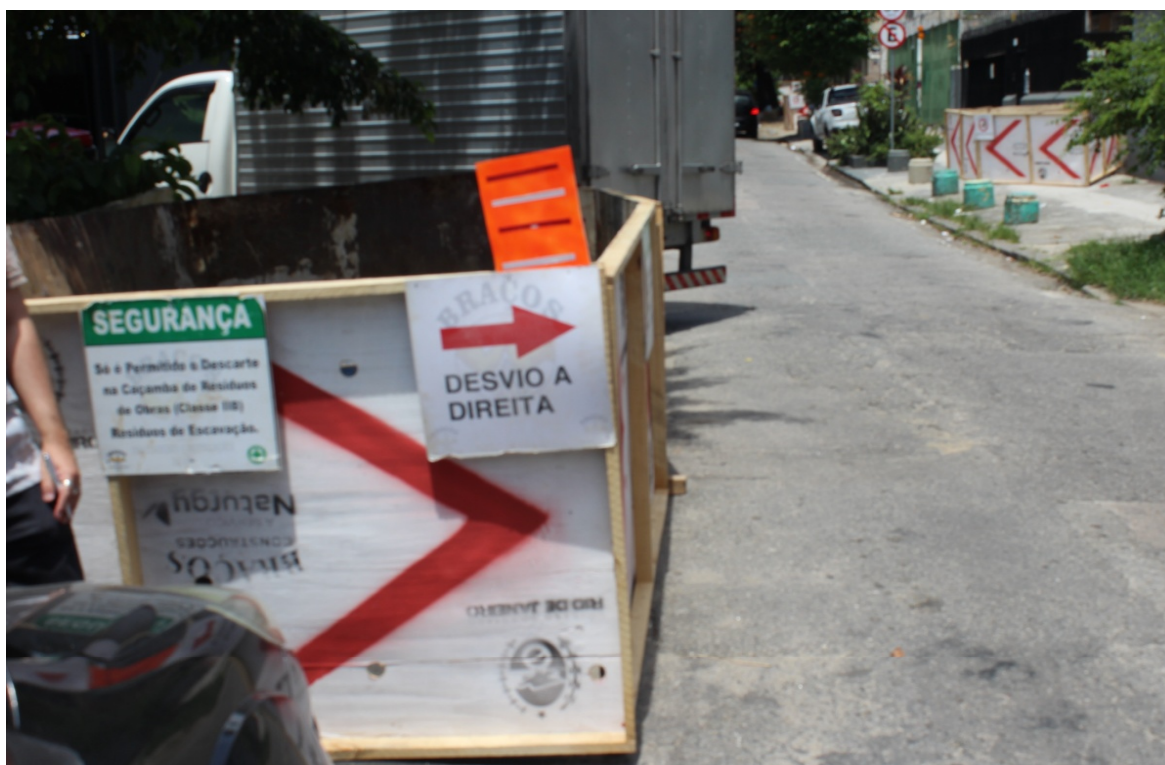
Foto 3: Área de descarte de entulho, com sinalização para desvio de trânsito, inclusive a noturna
