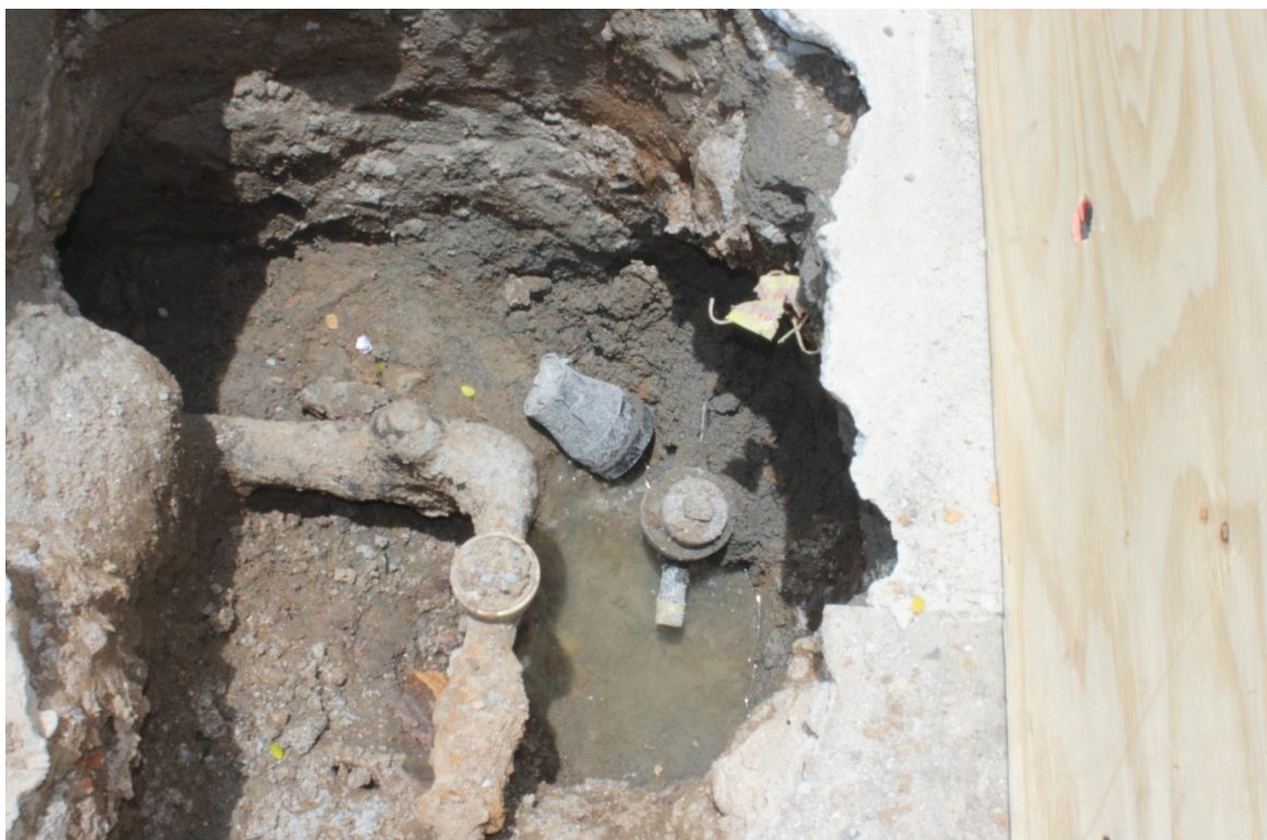
Foto 5: Abertura no passeio para substituição de ramal
