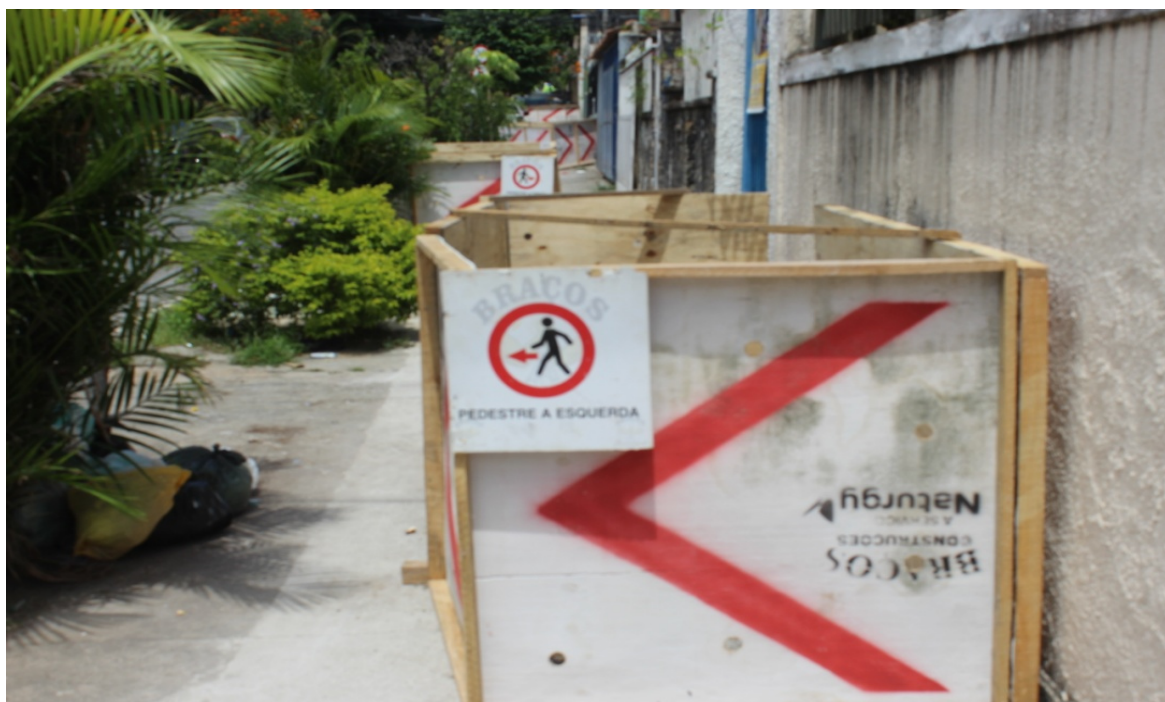
Foto 6: Intervenções pra conexão dos ramais. Sinalização para pedestres visível
