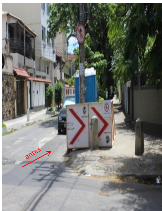
Foto 2: Recomposição provisória da via sinalizada com tinta, após observação da falta de sinalização
