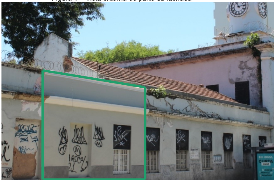
Figura 1 – Vista externa de parte da fachada
