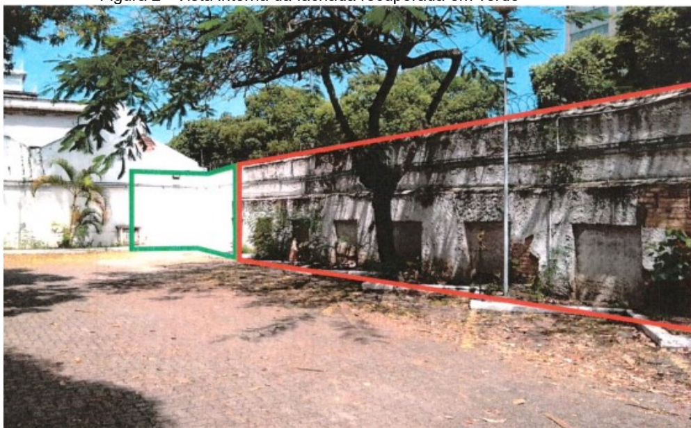
Figura 2 - Vista interna da fachada recuperada em verde
