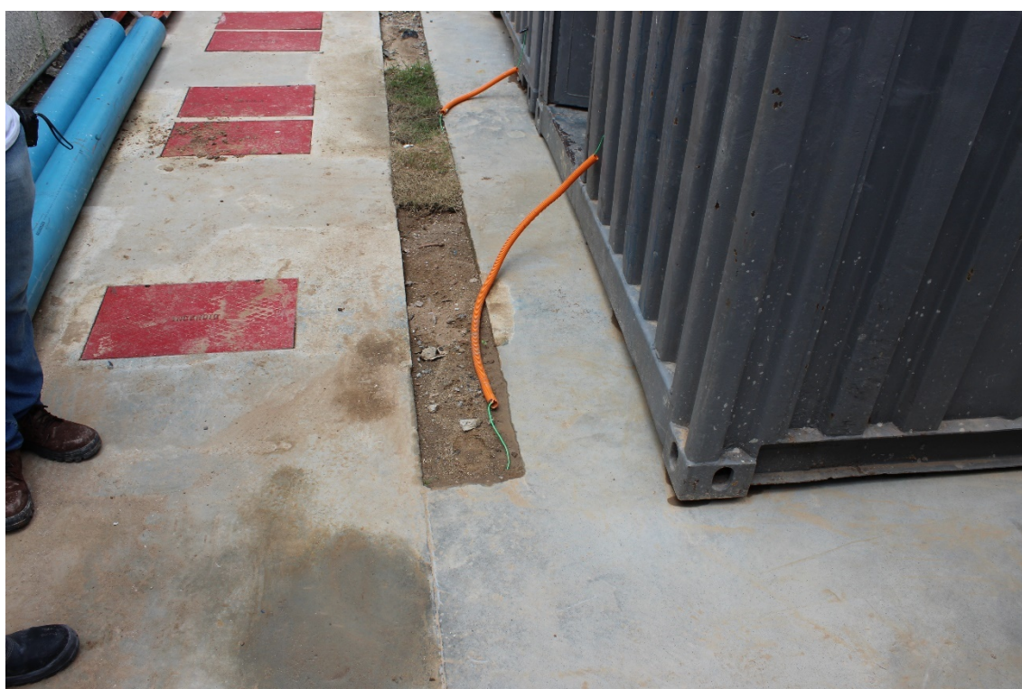
FOTO 6: Localização da ponta de rede interna (enterrada) que será interligada na rede externa
