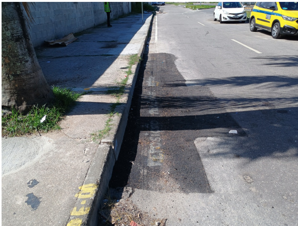
Foto 2: trecho de recomposição provisória e de interligação com a rede, em frente ao Condomínio One Offices.
