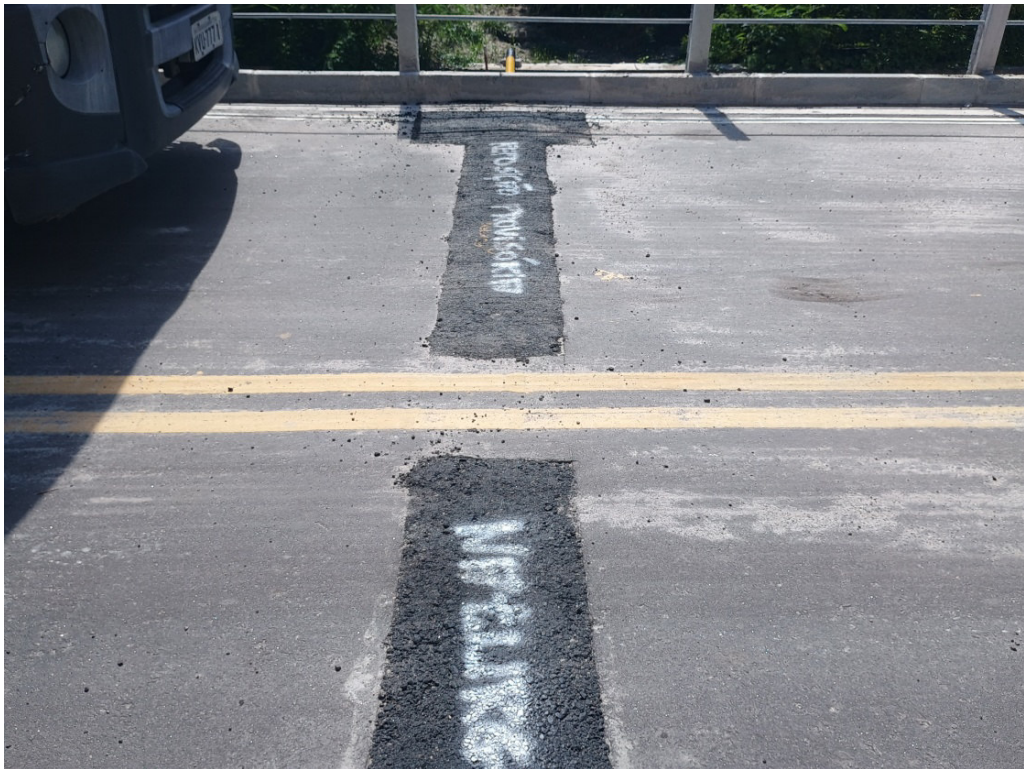
Foto 5: trecho de recomposição provisória.
