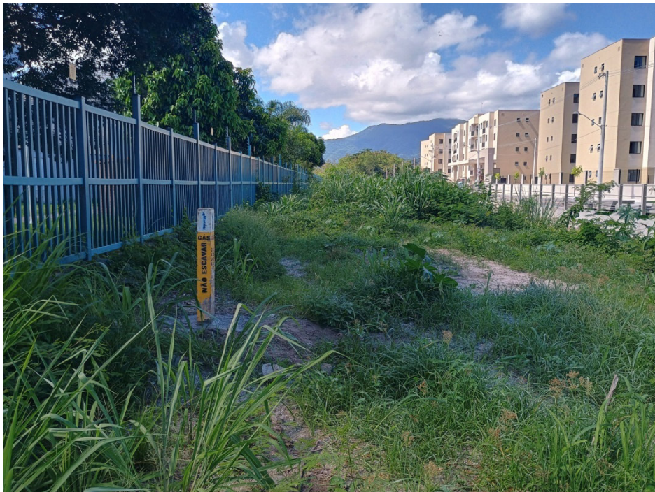
Foto 3: trecho de assentamento de tubulação por método não destrutivo identificado com marco vertical.
