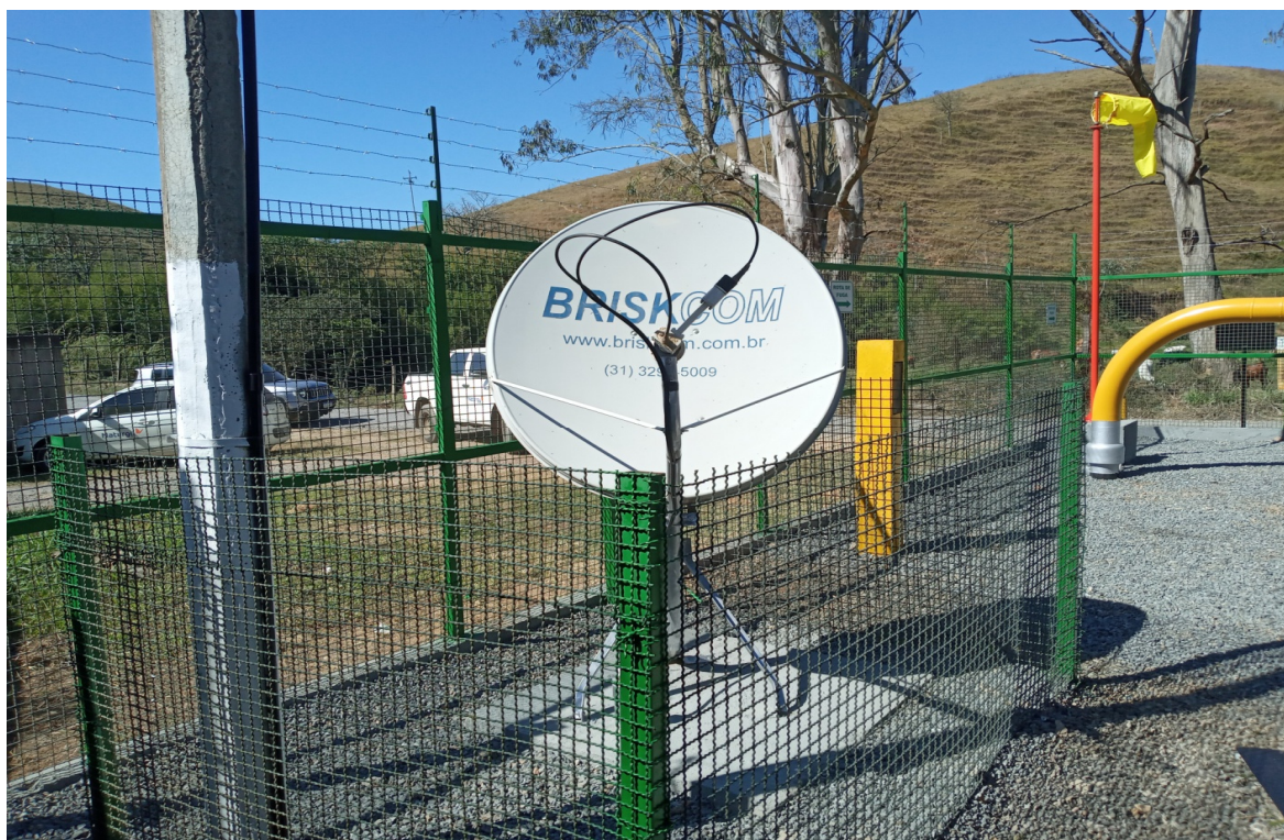
Foto 18: Antena do sistema de telemetria
