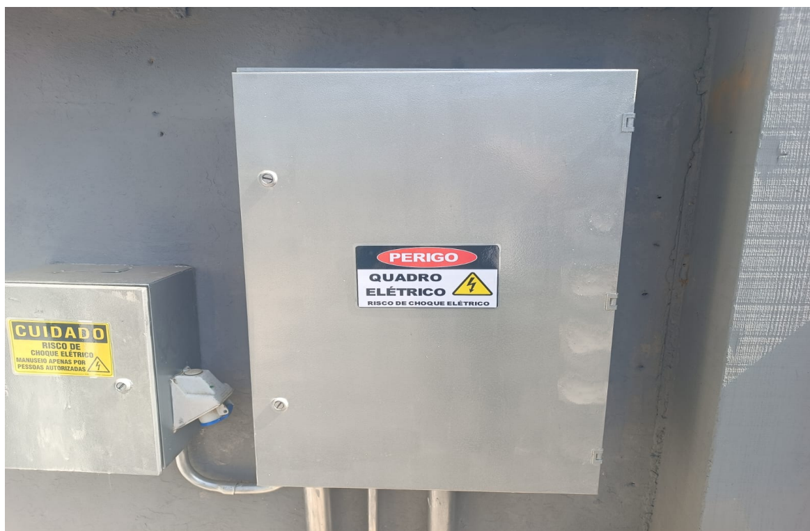
Foto 16: Painéis com sinalização de segurança
