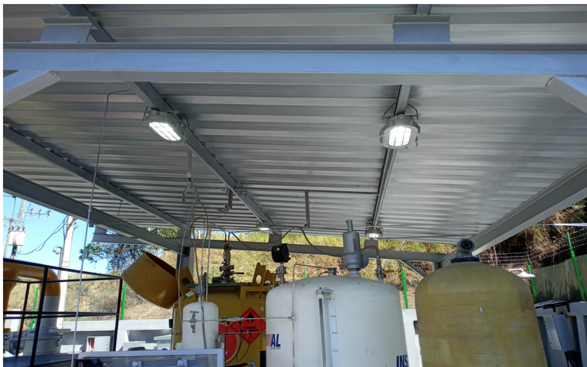
Foto 13: Cobertura da estação
