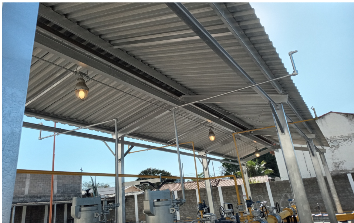
Foto 5: Cobertura da estação
