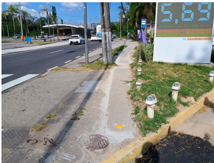
Foto 5: trecho de tubulação assentada por método destrutivo.
