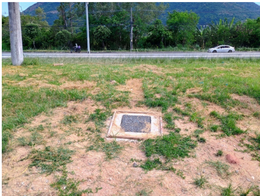
Foto 3: trecho de tubulação assentada por método não destrutivo.
