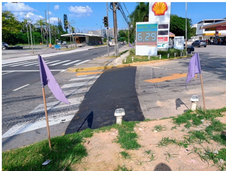
Foto 4: trecho de tubulação assentada por método destrutivo.
