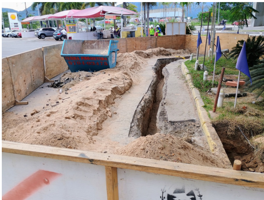
Foto 1: ponto de interligação do posto de combustível.
