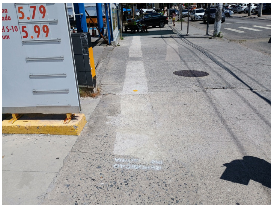
Foto 3: Trecho já assentado.
