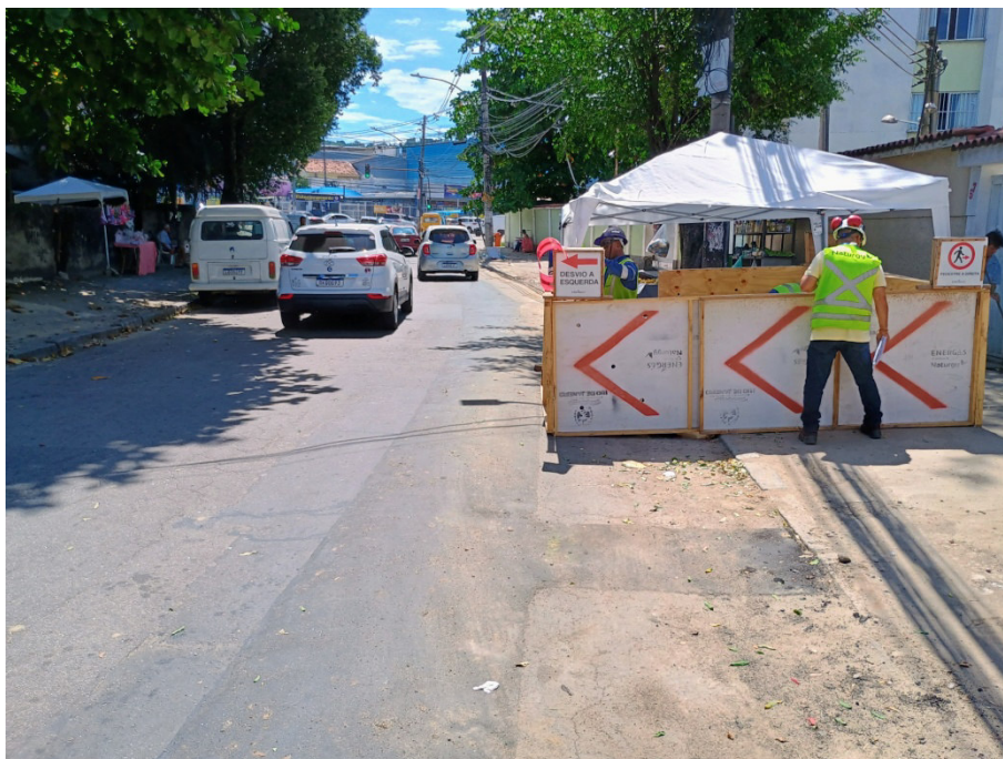
Foto 5: Trecho com recomposição provisória sem identificação.
