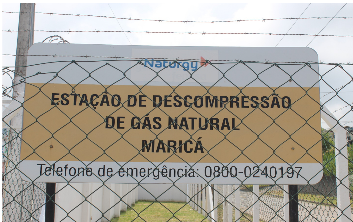
Foto 1: Placa de identificação da estação
