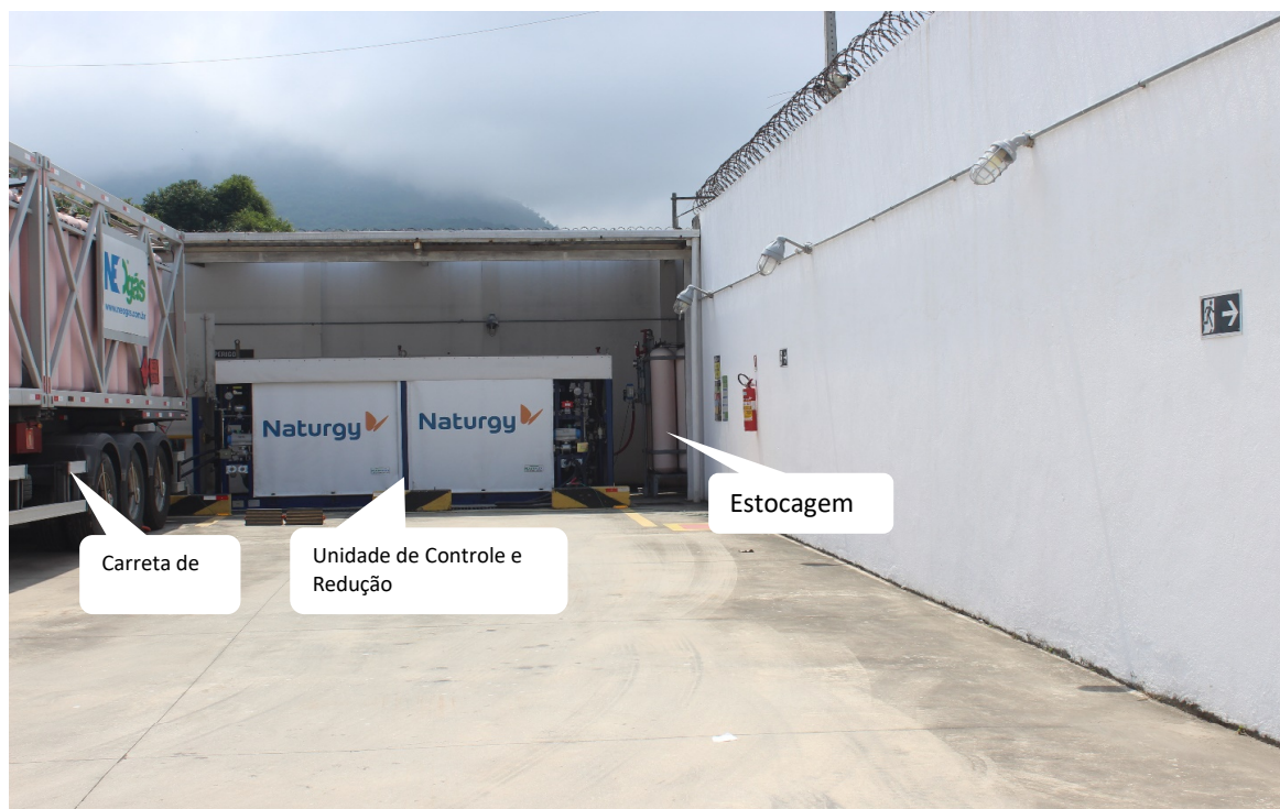
Foto 3: Área de descompressão
