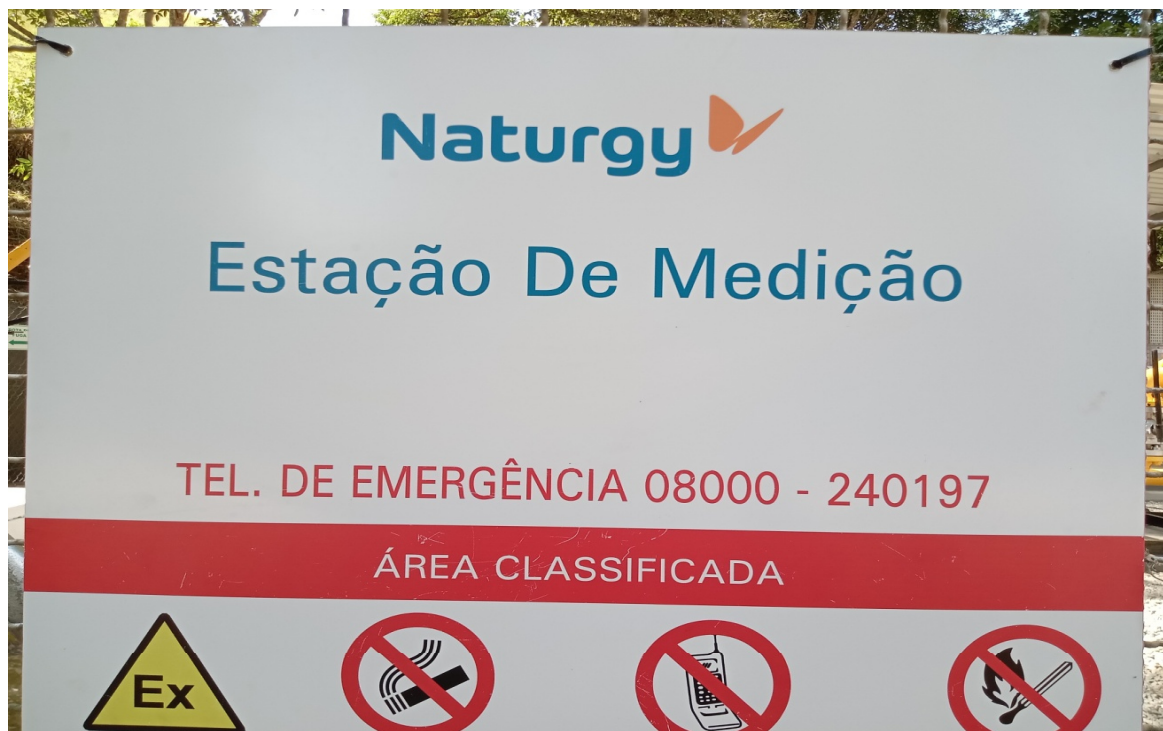
Foto 1: Placa de identificação da estação
