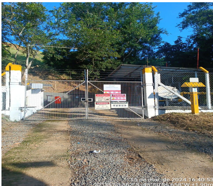
Foto 13: Correção do alinhamento e instalação de cerca sobre o portão
