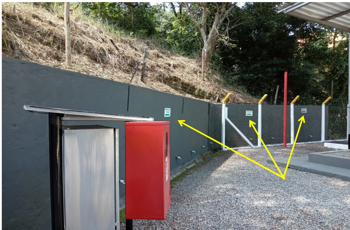
Foto 10: Placas de rota de fuga e extintor de incêndio
