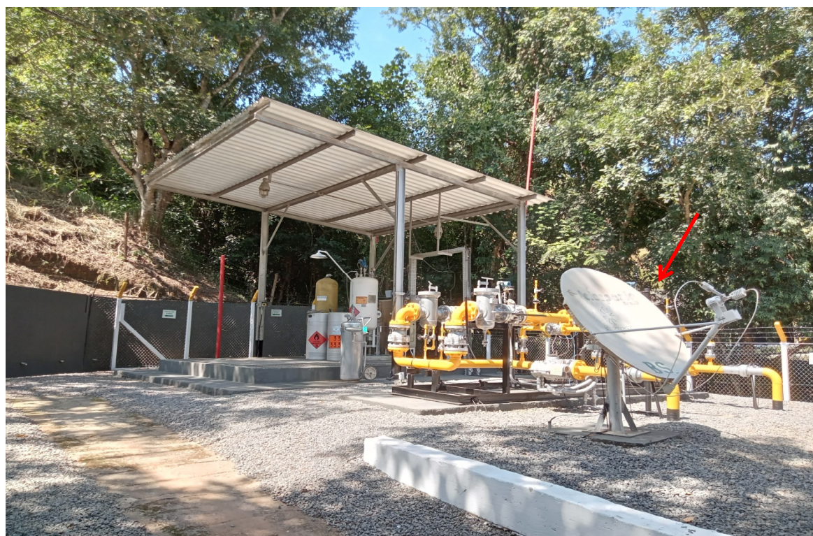
Foto 12: Antena do sistema de telemetria
