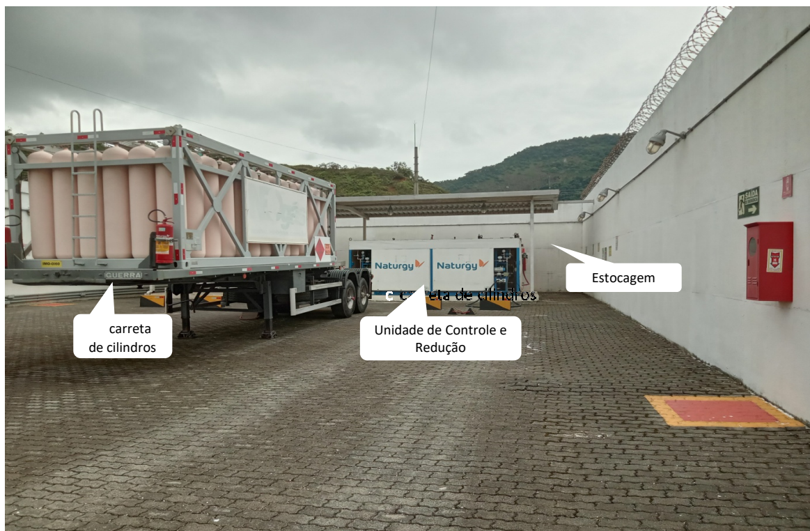
Foto 4: Área de descompressão
