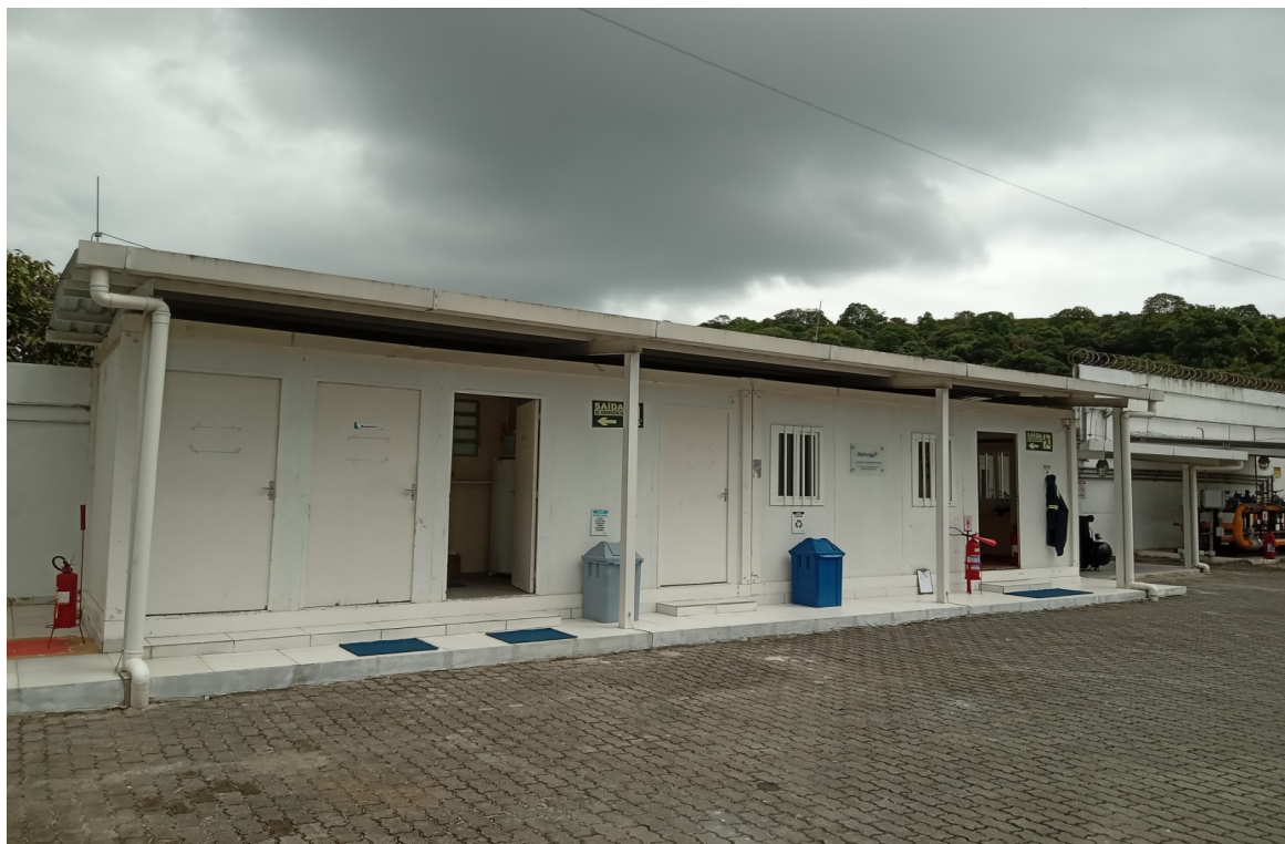
Foto 12: Banheiros, copa e sala de operação
