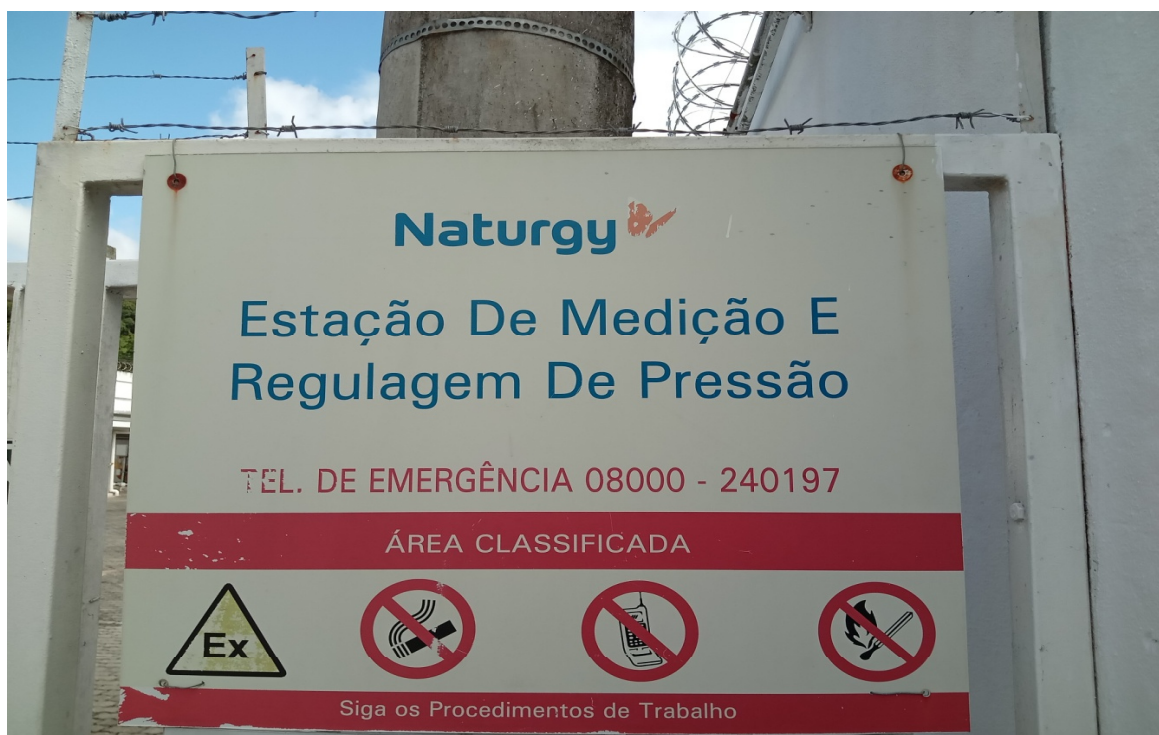
Foto 1: Placa de identificação da estação
