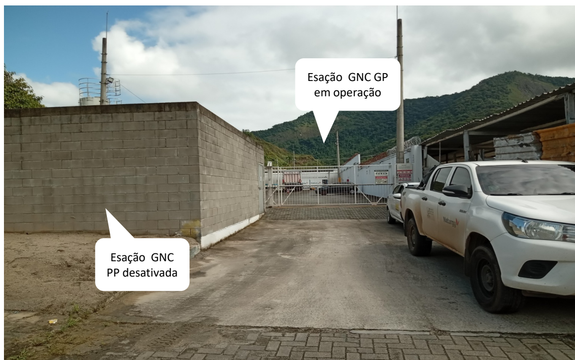
Foto 16: Acesso à estação de GNC
