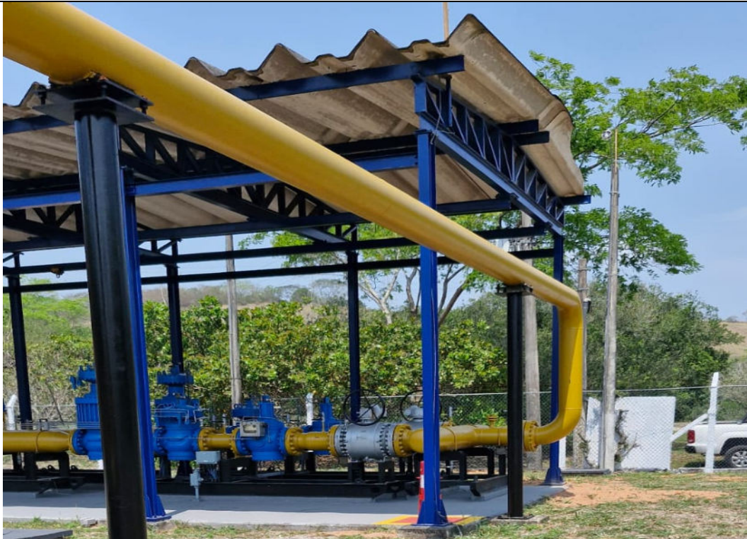
Foto 6: Chegada do gás ao trecho para regulagem.
