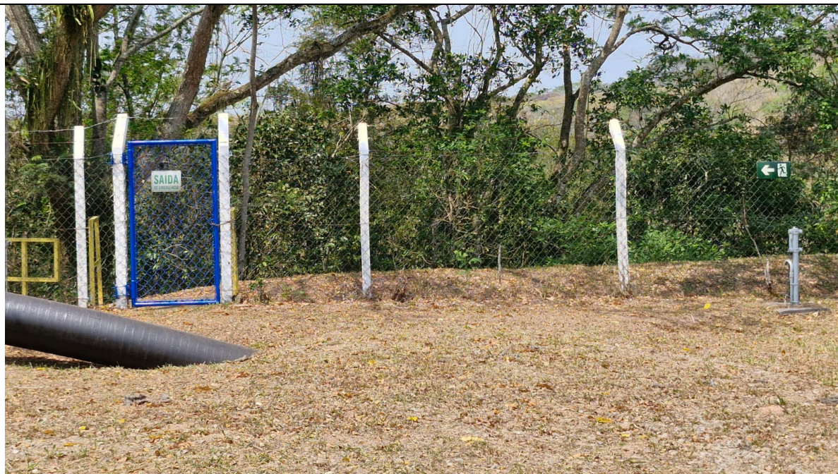
Foto 11: Cerca e sinalização da rota de fuga.
