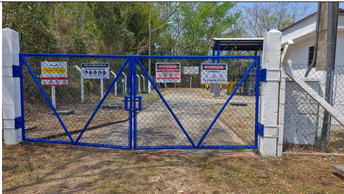
Foto 2: Entrada do City Gate, placas de sinalização de perigo, uso de EPI e presença de animais peçonhentos.
