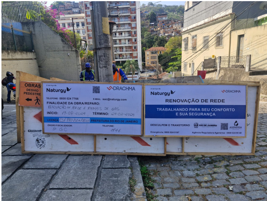
Foto 1: Identificação da obra de renovação de rede.
