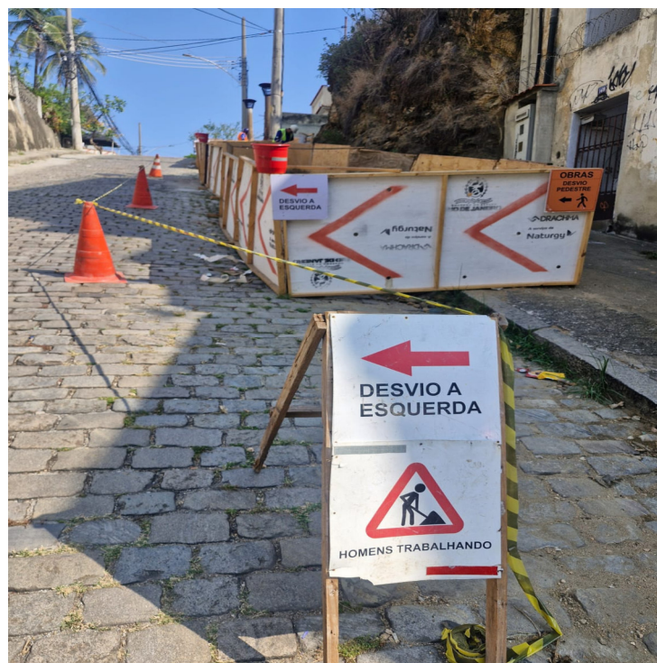
Foto 4: Obra na Rua Viana Drumond.
