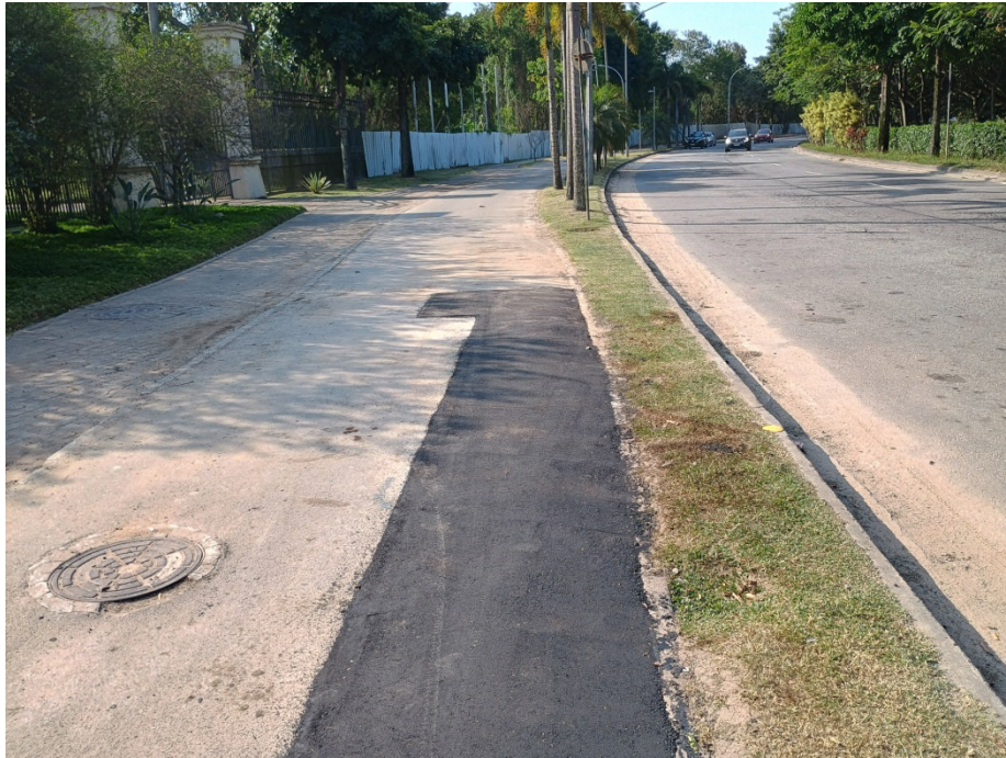
Foto 3: trecho de assentamento de tubulação por método destrutivo.
