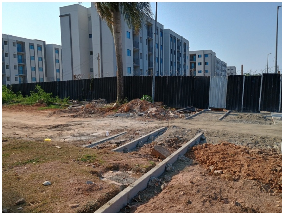
Foto 5: final da obra, na entrada do novo condomínio, Living Parque Jardim.
