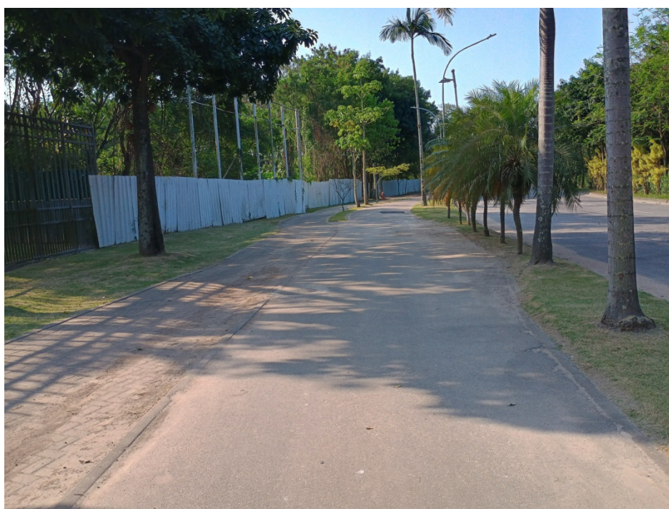
Foto 2: trecho de assentamento de tubulação por método não destrutivo.
