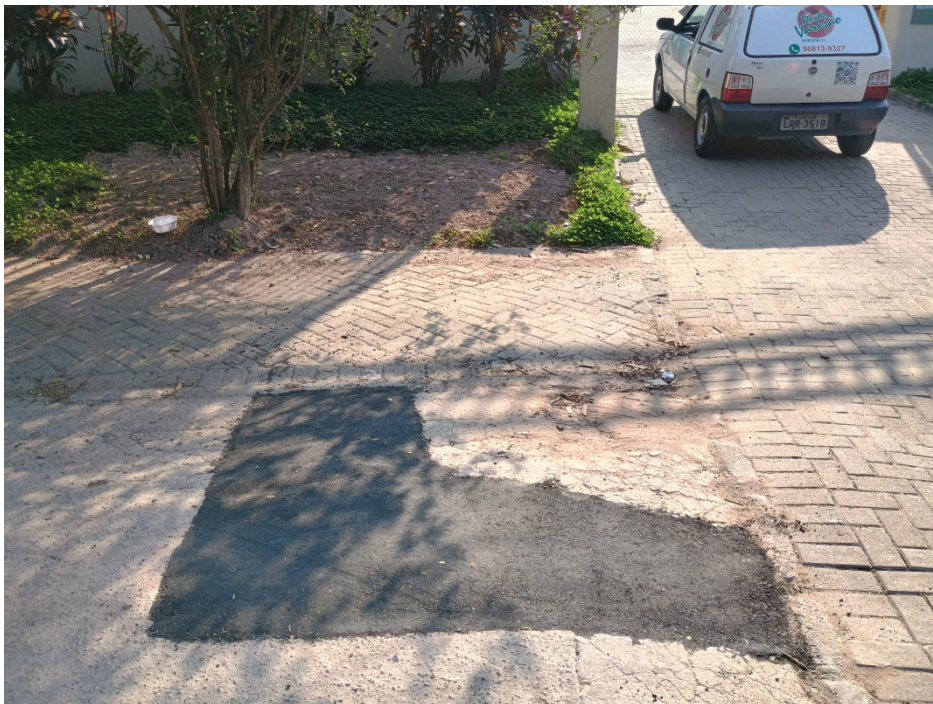
Foto 4: início da obra, na Av. Imperatriz Leopoldina, em frente ao número 1515.
