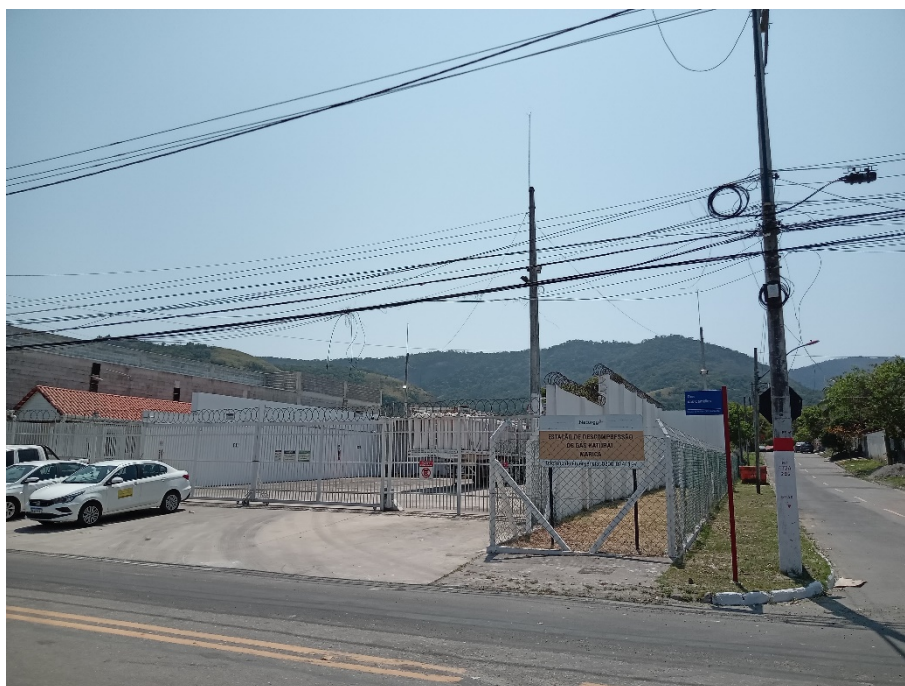
Foto 3: Vista geral da estação de descompressão.
