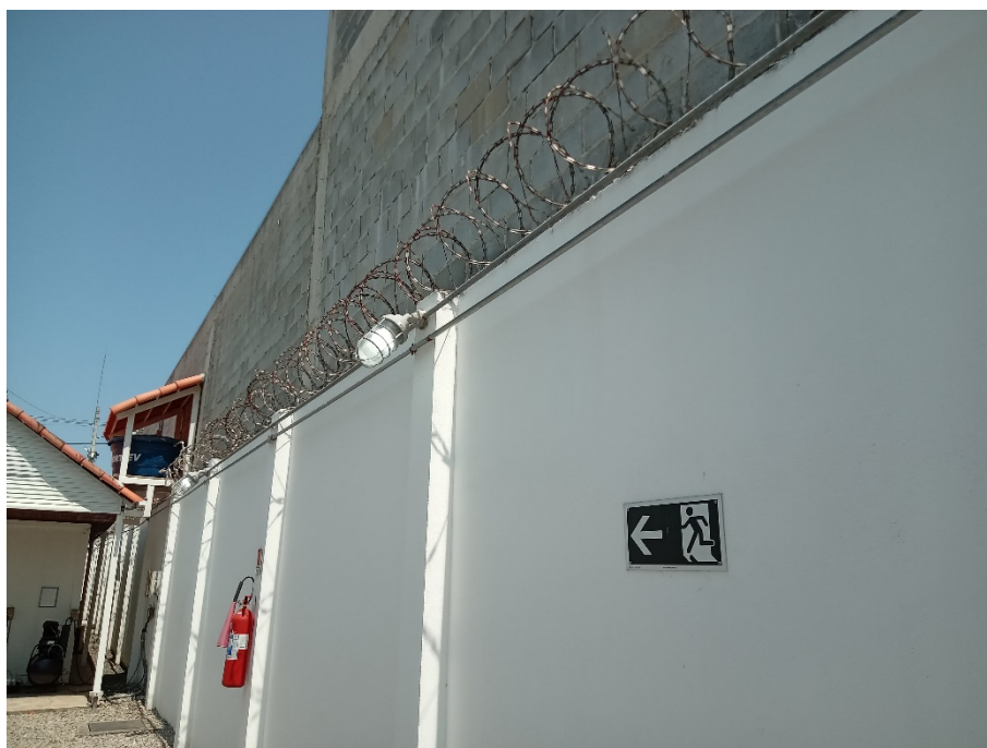
Foto 5: Muro da estação e sinalização de rota de fuga.
