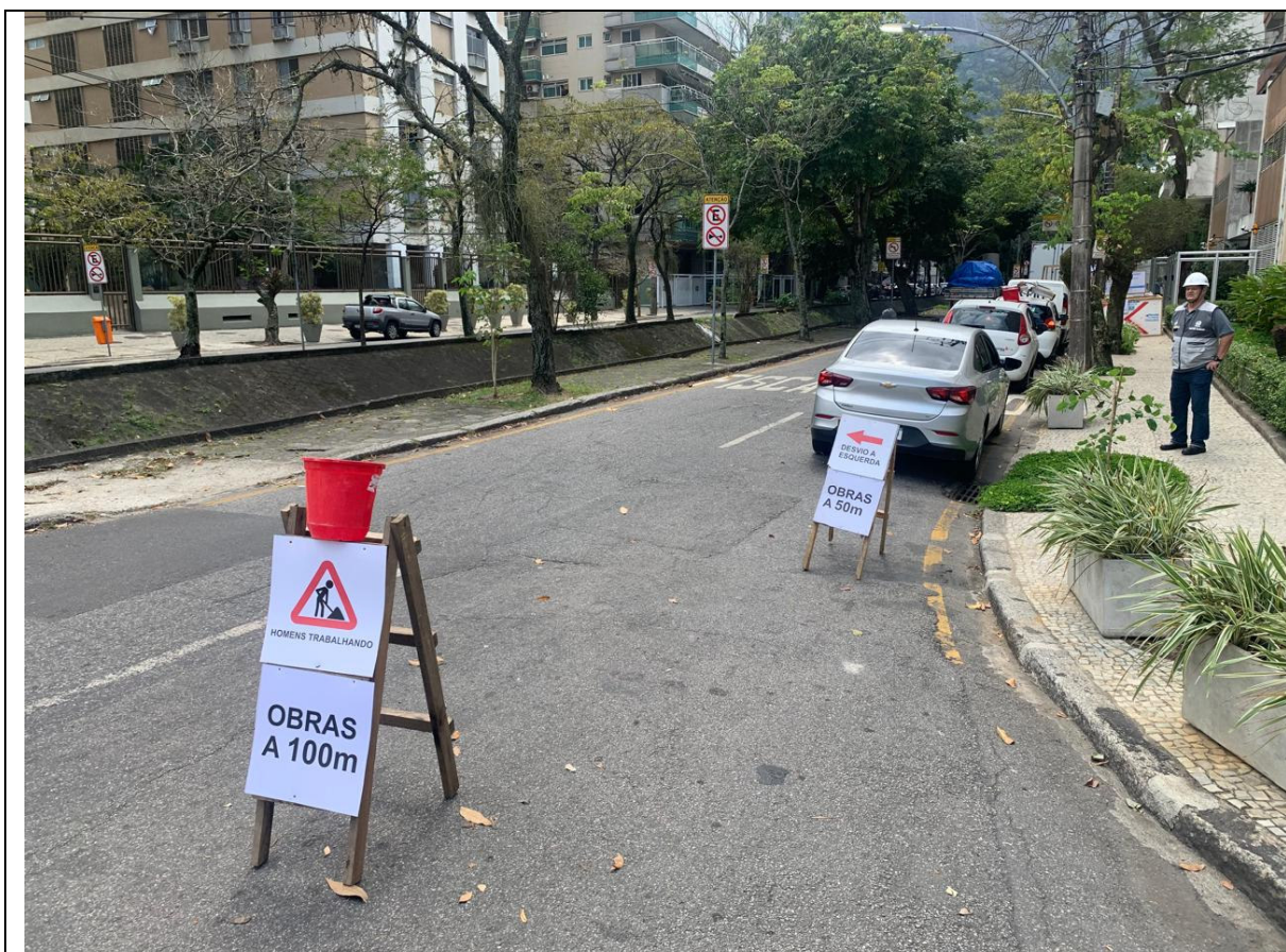
Foto 7: Início da obra com as sinalizações devidamente postas.
