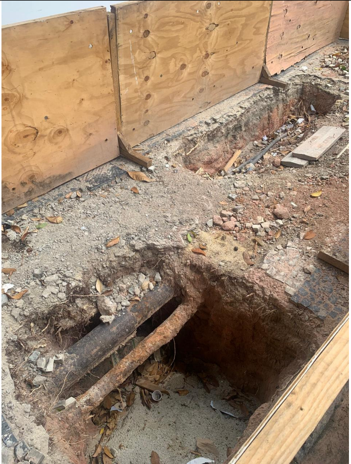
Foto 10: Cabos da light e tubulação da gás da Naturgy.
