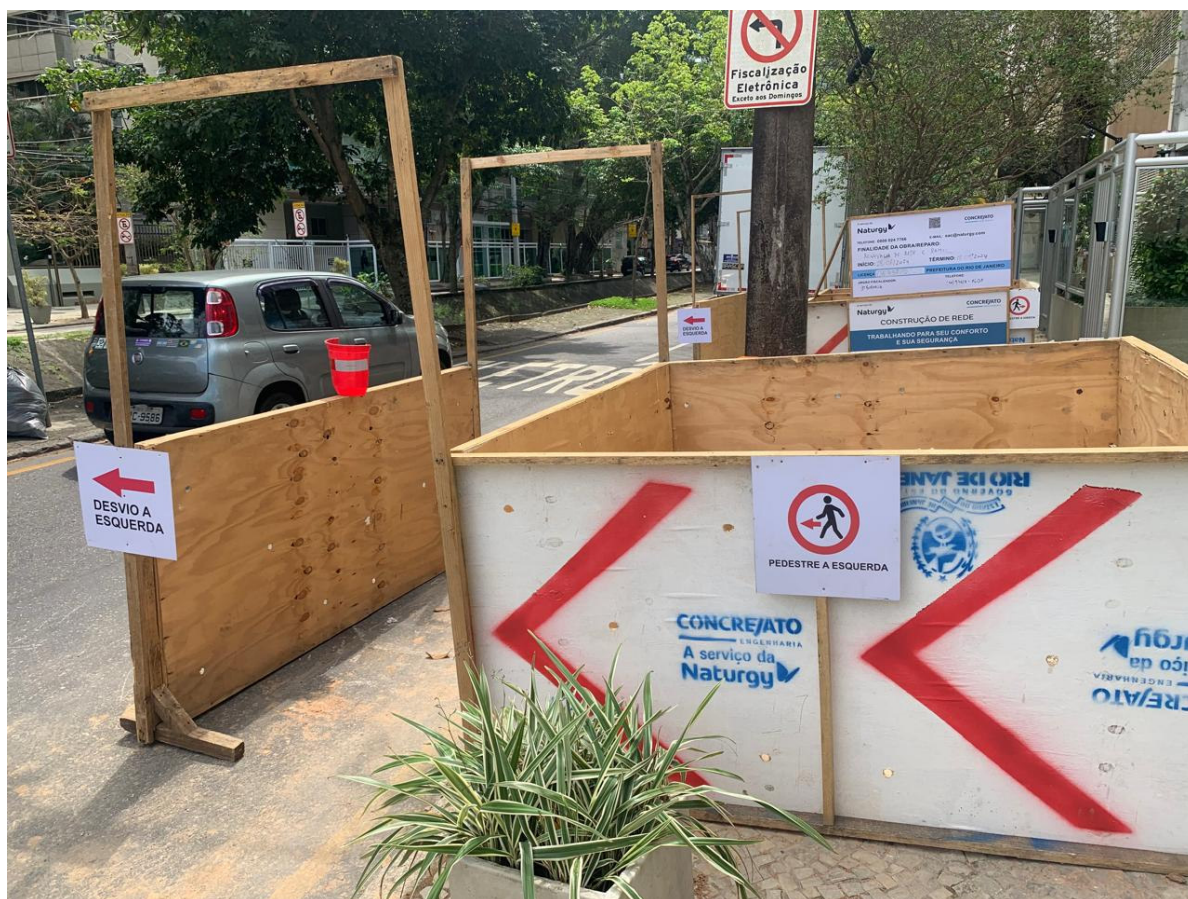
Foto 3: Passagem de pedestres com as sinalizações.
