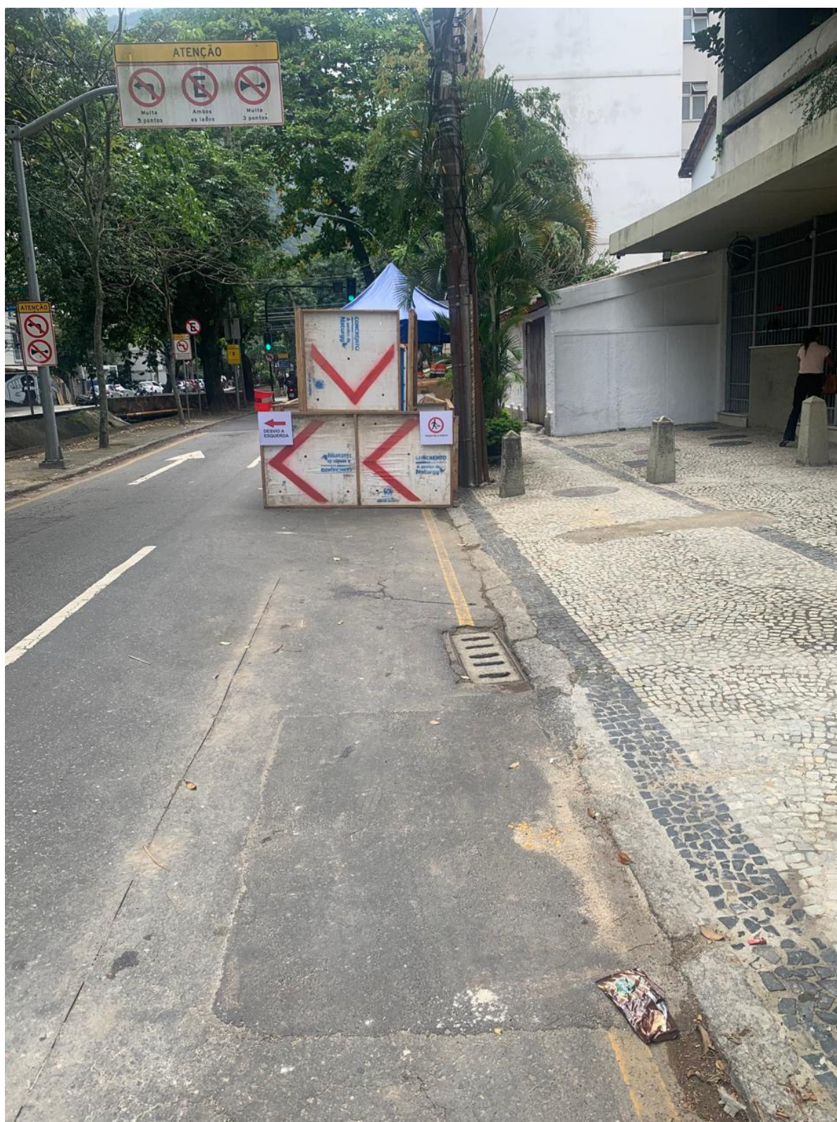
Foto 2: assentamento na via de veículos.
