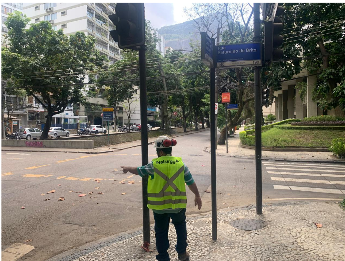
Foto 6: Final da obra na esquina da Rua Saturnino de Brito.
