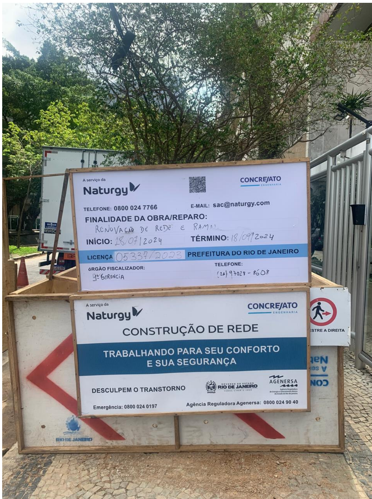
Foto 1: placa da obra de renovação.
