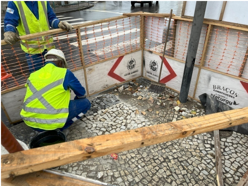
Foto 4: Recomposição do pavimento realizada por funcionários da obra.
