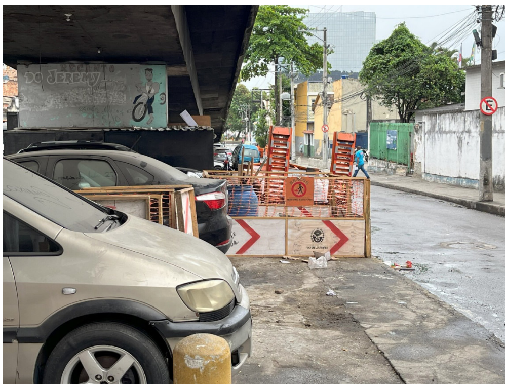
Foto 6: Primeira interligação de rede, parcialmente executada.
