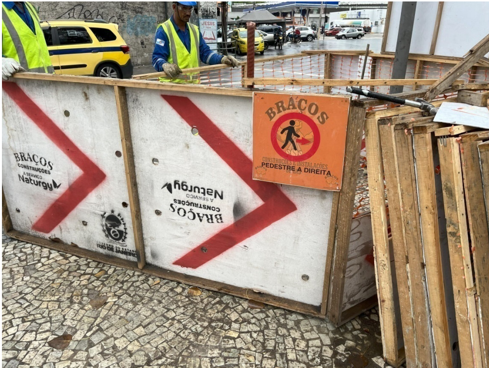
Foto 3: Isolamento e sinalização de desvio de pedestre.
