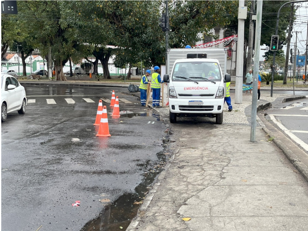
Foto 1: Local de início da obra, no início da Rua da América.
