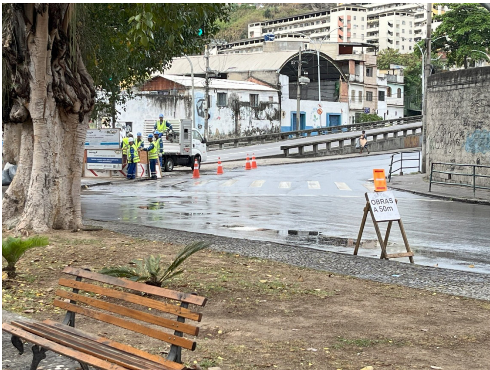
Foto 10: Placa de aviso de obra na Praça Santo Cristo; e início da obra na Rua da América à frente.
