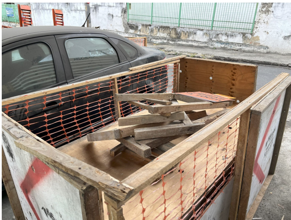
Foto 8: Armazenamento de material.
