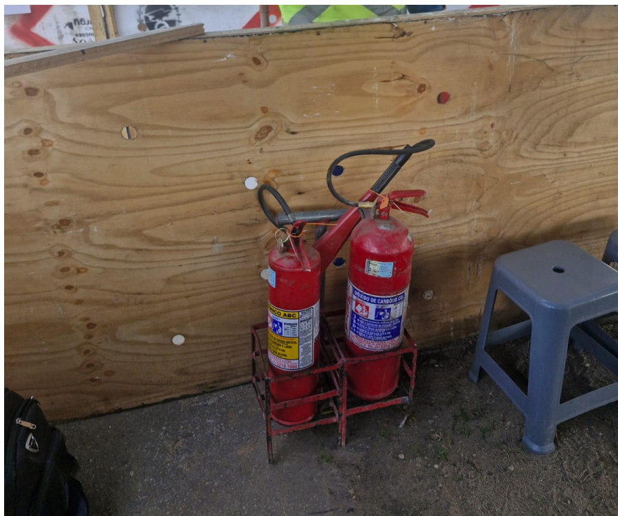
Foto 7: Extintores de incêndio.
