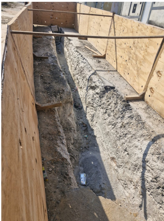
Foto 3: trecho usado método destrutivo de vala a céu aberto.
