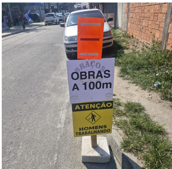
Foto 8: Identificação de obra.
