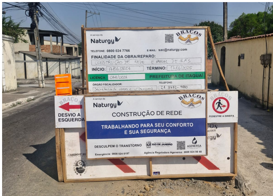
Foto 1: placa da obra de expansão de rede.
