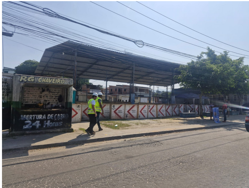
Foto 5: Obra na rua Joaquim Nabuco.
